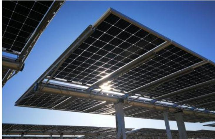
Figura 4.3: Esempio di struttura tipo tracker monoassiale
