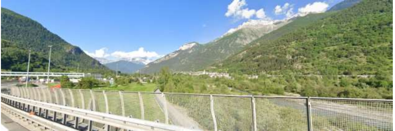
Figura 15– Stato attuale dell’area di cantiere presa dall’autostrada A 32.
