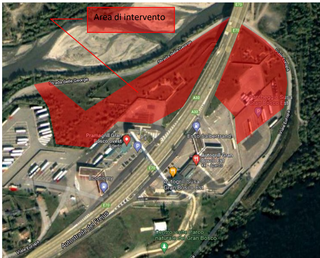
Vista aerea dell'area di intervento
