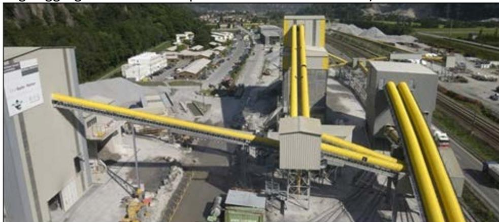
Figura 13- – Cantiere AlpTransit (Pollegio) – Movimentazione dei materiali provenienti dagli scavi e degli aggregati mediante nastri trasportatori (si possono anche osservare sulla sinistra l'impianto di valorizzazione, al centro i silos di stoccaggio degli aggregati e sulla destra la centrale di betonaggio).
