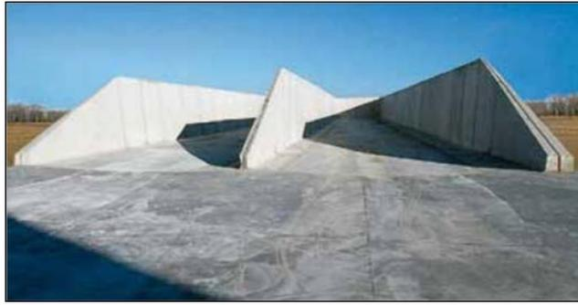
Figura 6- – Piazzole di deposito smarino con elementi prefabbricati in calcestruzzo
