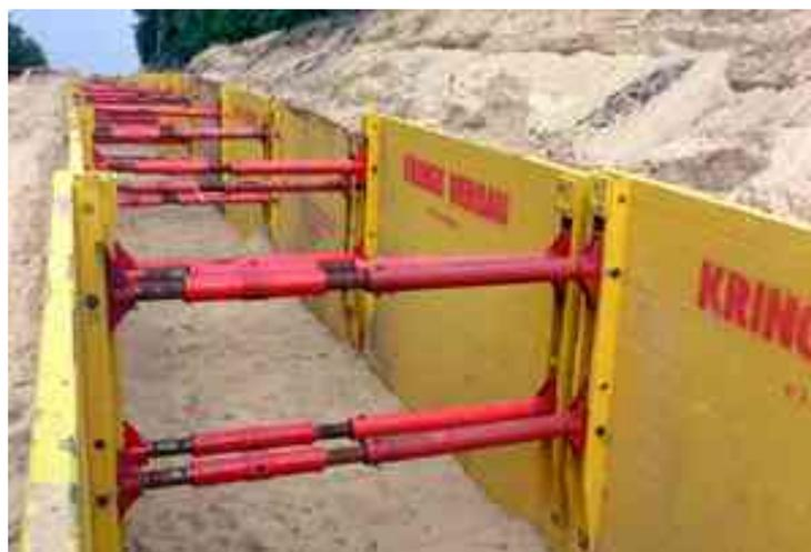
Esempio sistema di cassetture di protezione
