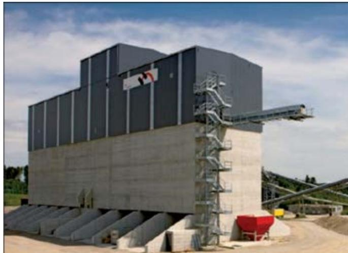
*Figura 3- – Impianto di valorizzazione dei materiali di scavo – Particolare della tipologia di schermatura contro rumore e polveri*
