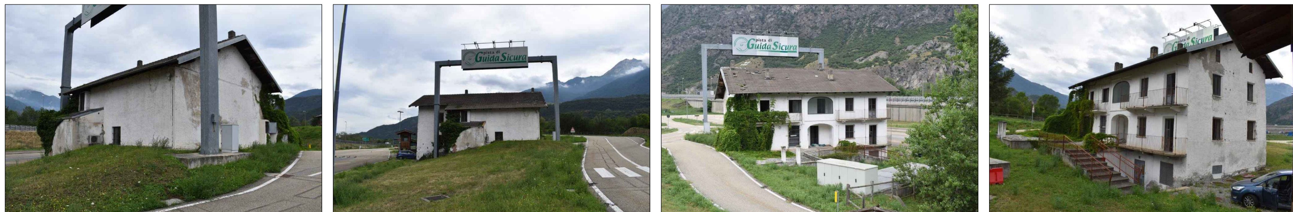
Il portale con insegna deve essere oggetto di rimozione unitamente alle sue fondazioni
