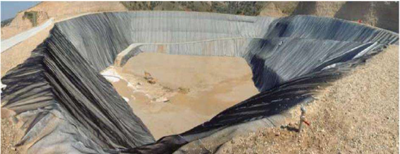
Figura 3: Esempio di utilizzo di una geomembrana
