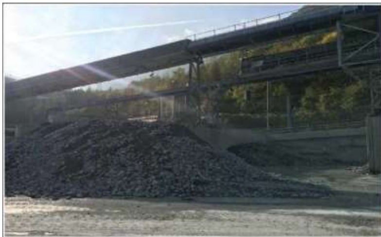
Figura 4: Immagine esemplificativa di materiale accantonato temporaneamente nell'area esterna del cantiere
