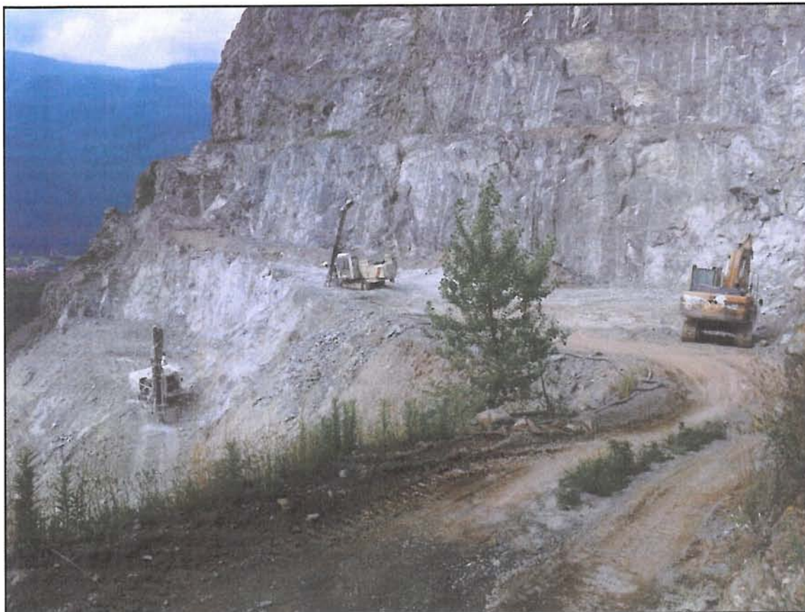
Figura 17 – Berma a quota 445 m s.l.m. Mezzi di cantiere impegnati nelle fasi di coltivazione lungo i fronti di cava
