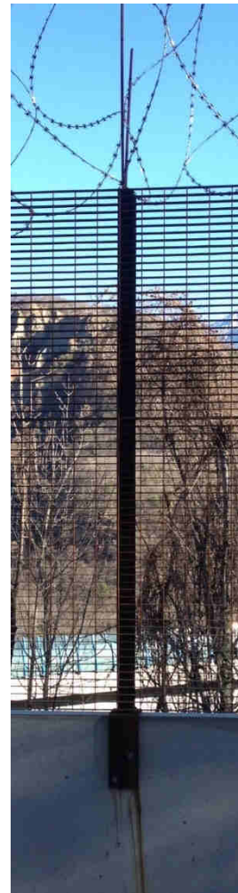
Figura 1 : Particolare recinzione antintrusione esterna
