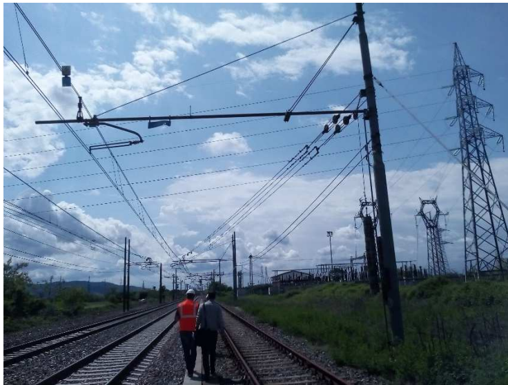
Figura 10: Pali e mensole esistenti in prossimità dell'attuale precedenza dispari
