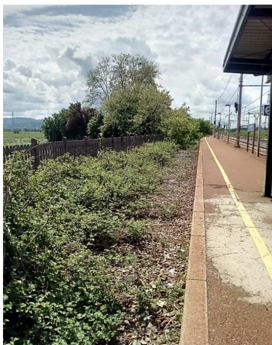
Figura 2: Stazione Torrazza – Binario di precedenza pari integralmente dismesso
