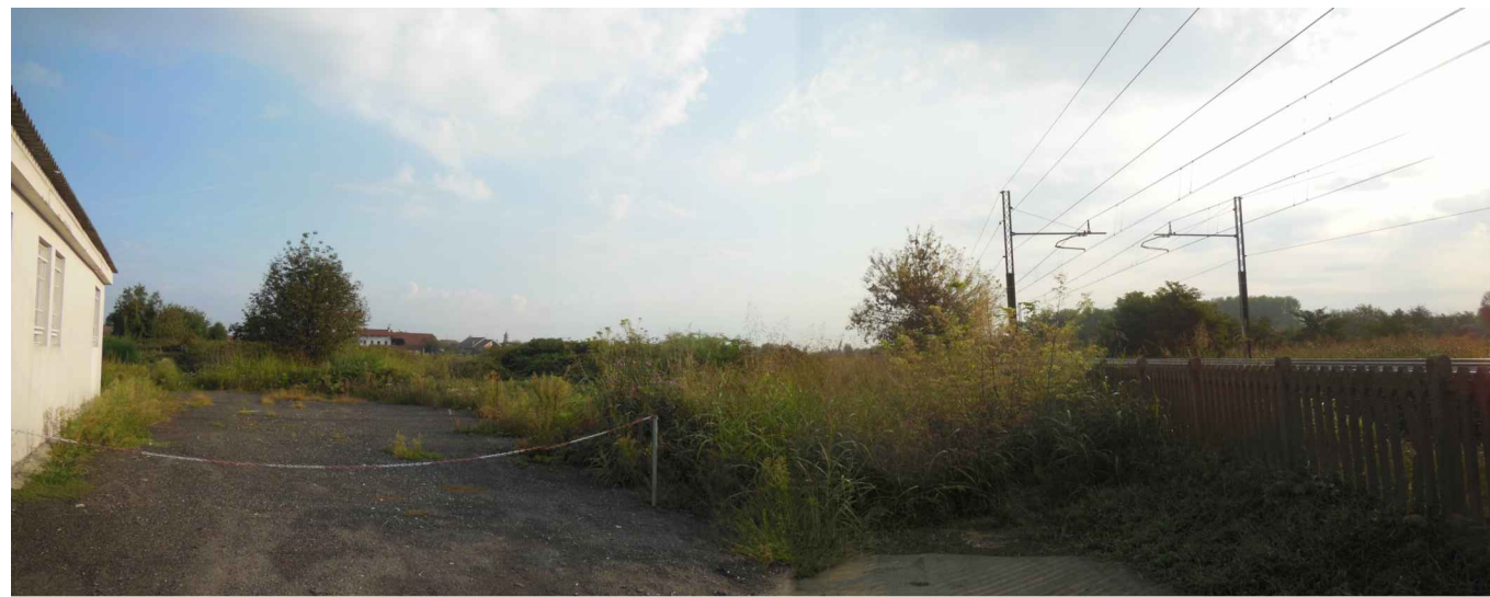
P9 - Vista dell'area dello sfiocco ferroviario da via San Giovanni Bosco
