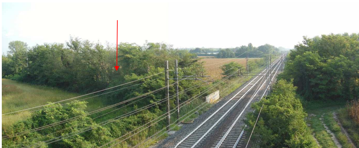
Figura 21: Punto di attraversamento del nastro trasportatore (freccia rossa) della Gora dei Mulini dopo l'incrocio con strada Bergolo-Monferrina
