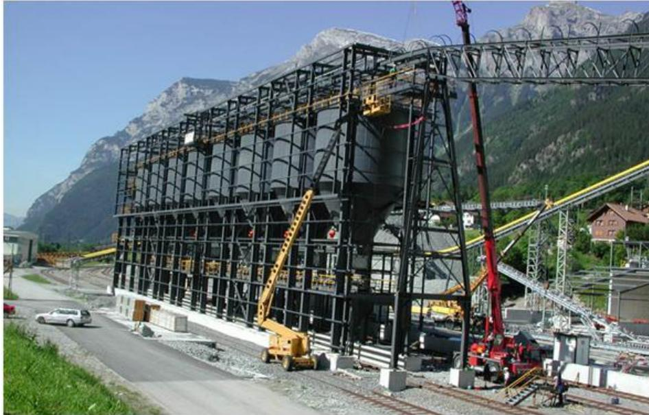
*Figura 8 – Cantiere AlpTransit (Amsteg) – Impianto di caricamento su treno in corso di costruzione (a fine lavori l'impianto sarà completamente chiuso, vedere Figura 7) si noti anche la movimentazione dei materiali mediante nastri trasportatori chiusi*
