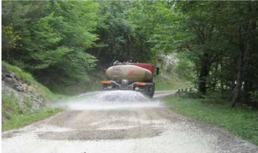
*Figura 12 – Bagnatura strade di cantiere non pavimentate (Fonte: Provincia di Forlì – Servizio Agricoltura Spazio Rurale, Flora e Fauna)*
