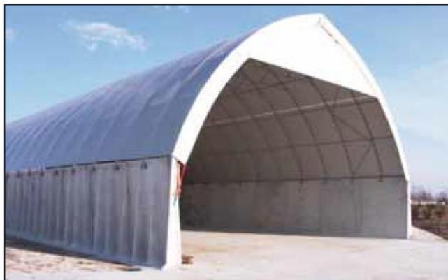
*Figura 14 – Silos orizzontale con copertura tipo “tenso-struttura”*
