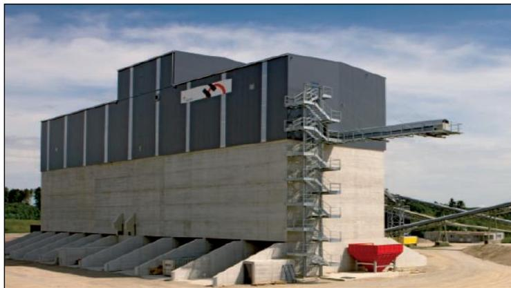
*Figura 4 – Impianto di valorizzazione dei materiali di scavo – Particolare della tipologia di schermatura contro le polveri*
