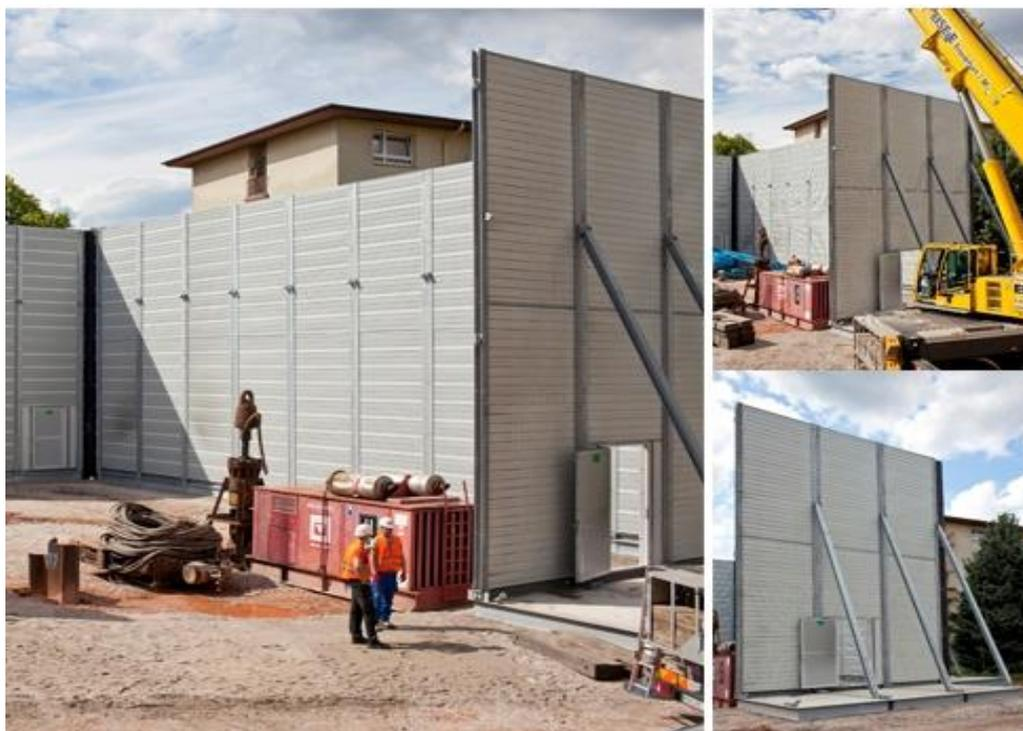
*Figura 23 – Esempio di barriera fonoisolante mobile*
