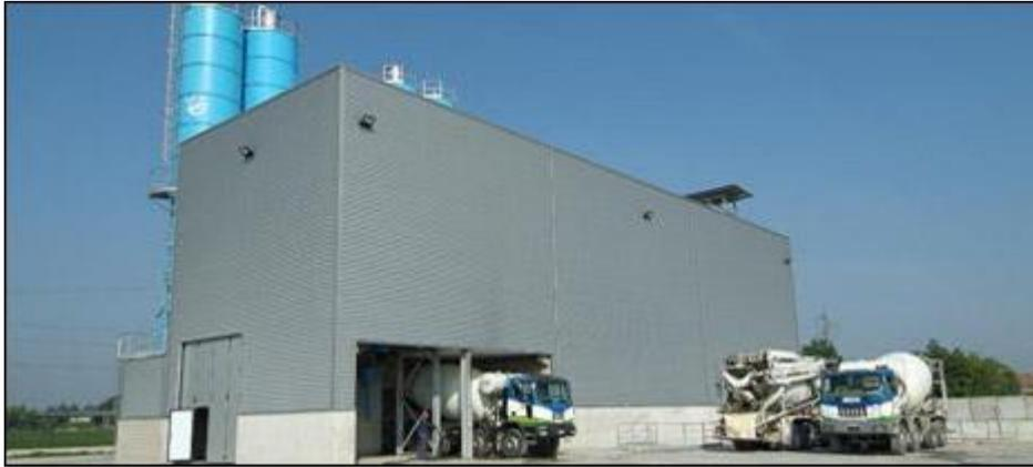
*Figura 2 – Impianto di betonaggio – Particolare della tipologia di schermatura contro le polveri*
