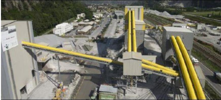
*Figura 5 – Cantiere AlpTransit (Pollegio) – Movimentazione dei materiali provenienti dagli scavi e degli aggregati mediante nastri trasportatori (si possono anche osservare sulla sinistra l'impianto di valorizzazione, al centro i silos di stoccaggio degli aggregati e sulla destra la centrale di betonaggio)*
