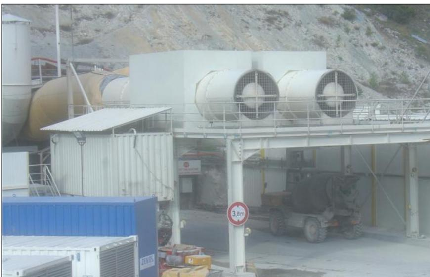
*Figura 6 – Impianto di ventilazione – Particolare dei silenziatori e carter di insonorizzazione dei motori*
