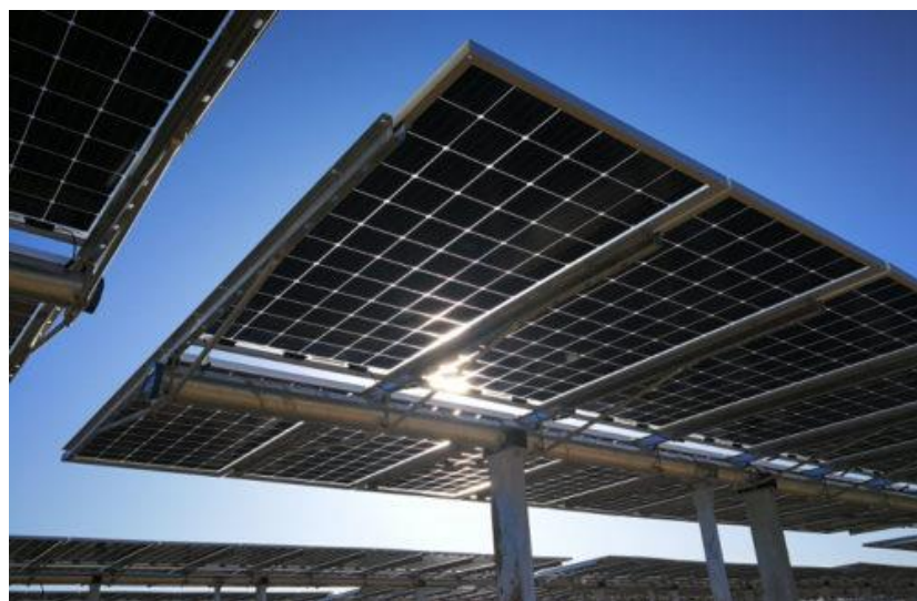
Figura 3.3 Esempio di struttura a tracker monoassiale
