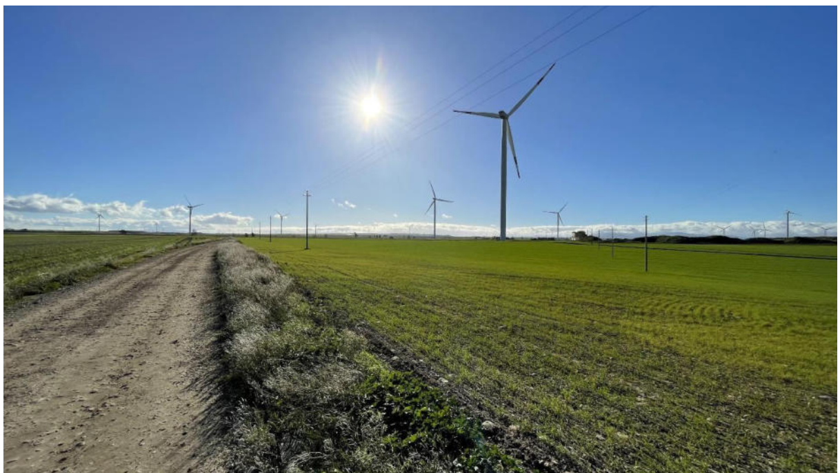
Figura 2.3: Linea Elettrica di Media tensione localizzata lungo il settore A dell'impianto
