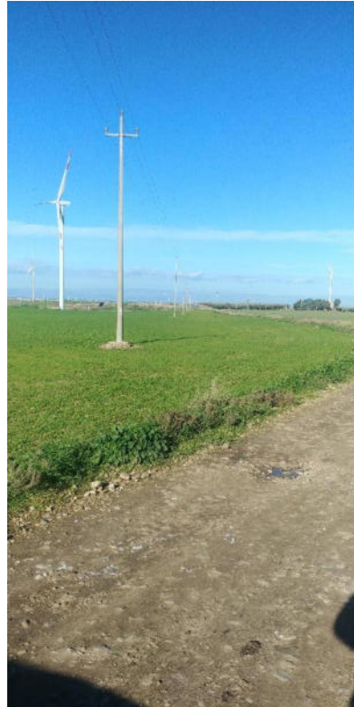
Figura 2.2: Linea Elettrica di Media tensione localizzata lungo il settore A dell'impianto
