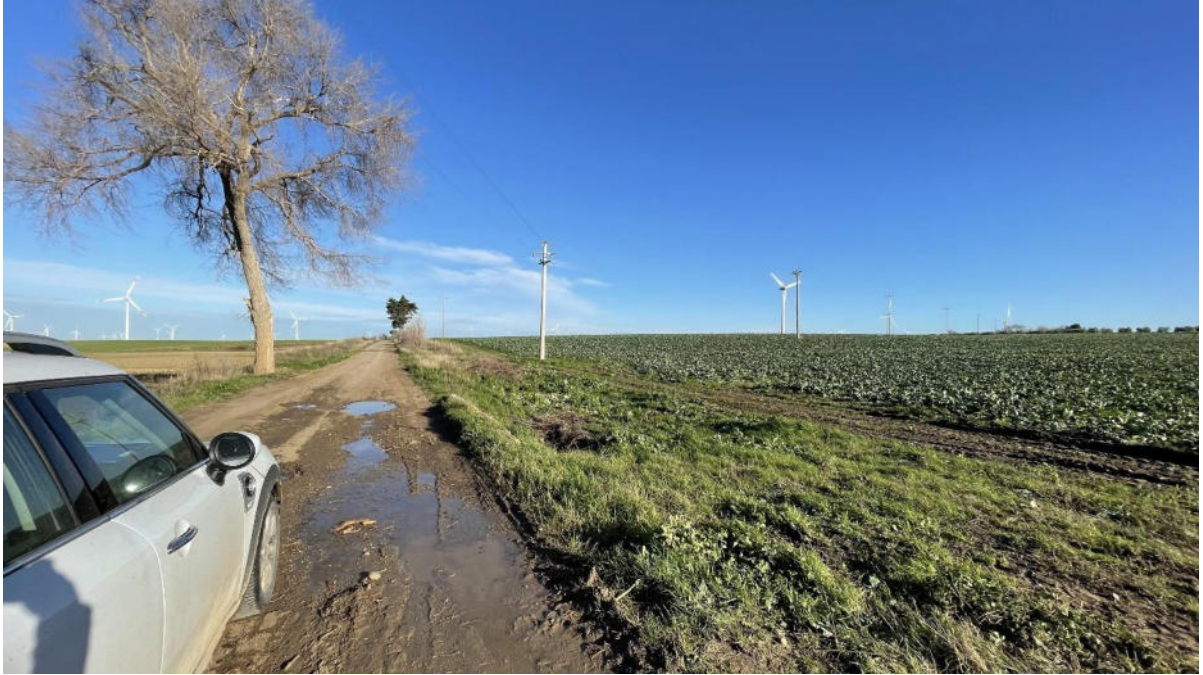
Figura 2.4: Linea Elettrica di Media tensione localizzata nel settore G dell'impianto
