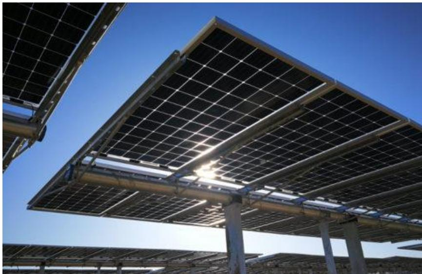
Figura 2.9 Esempio di struttura a tracker monoassiale
