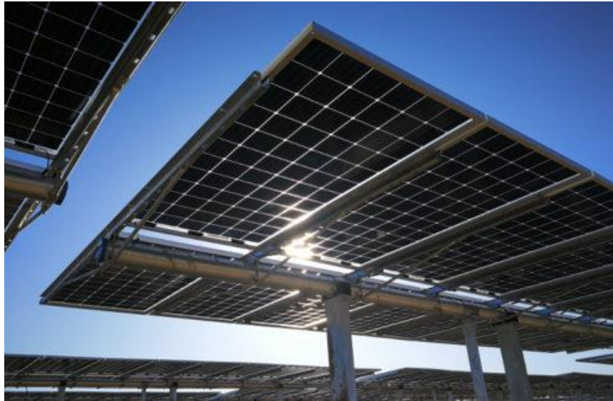
Figura 2.8 Esempio di struttura a tracker monoassiale
