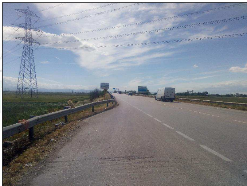
Foto. 12.1 – SS673 Vista ovest
