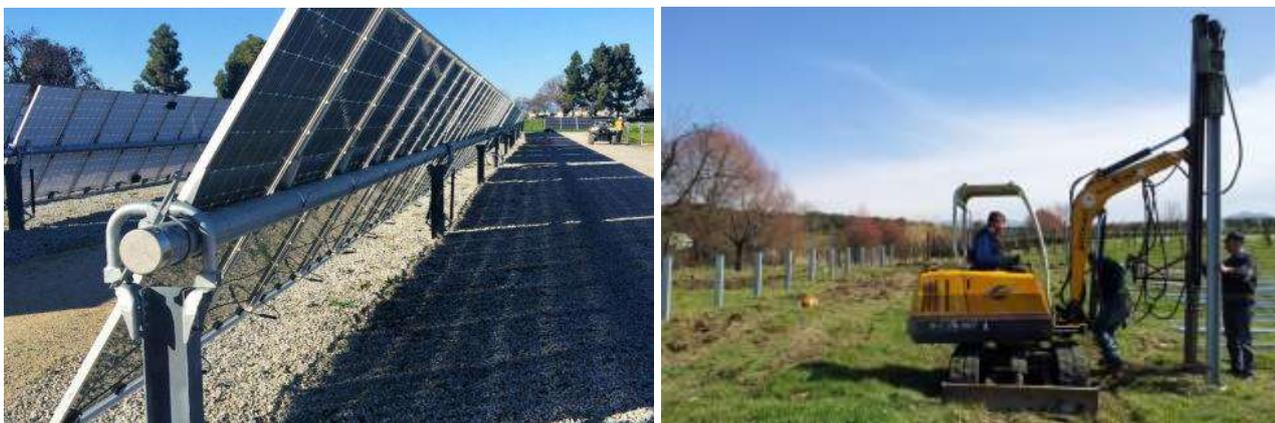
*Figura 3 – Esempio di posa delle strutture portanti*
