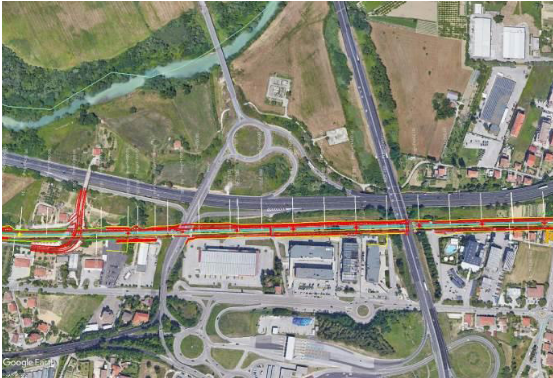
Figura 17 – Opere di scavalco dell'Autostrada Adriatica e dello svincolo di uscita dell'Asse Attrezzato Industriale
