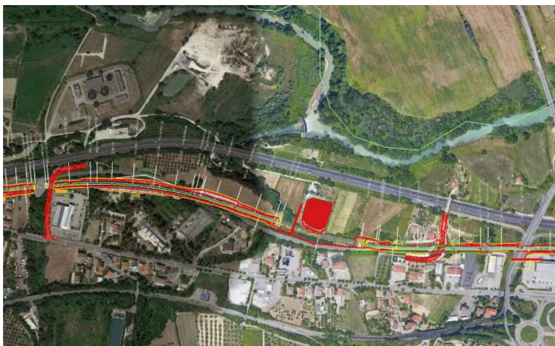
Figura 21 – Raddoppio ferroviario dal km 7+700 al km 8+900
