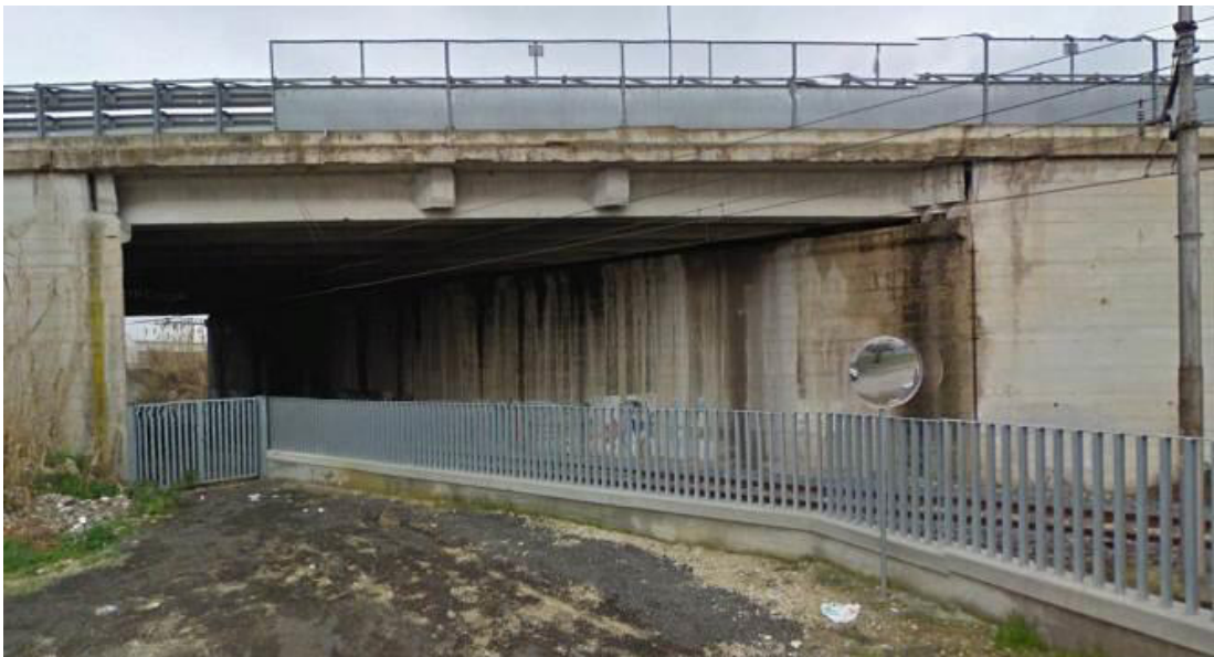
Figura 29 – Sotto-attraversamento esistente Asse Attrezzato PE-CH
