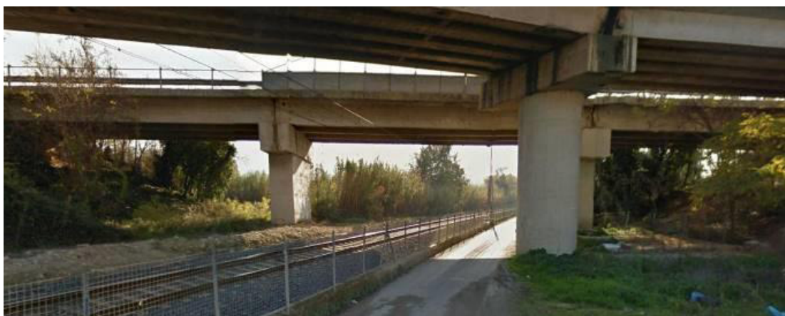
Figura 35 – Sotto-attraffersamento CVF rampa di raccordo dell'Autostrada A25
