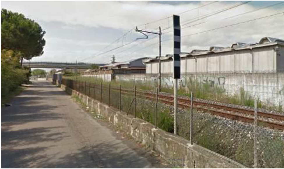
Figura 6-Capannoni industriali al km 1+780 circa
