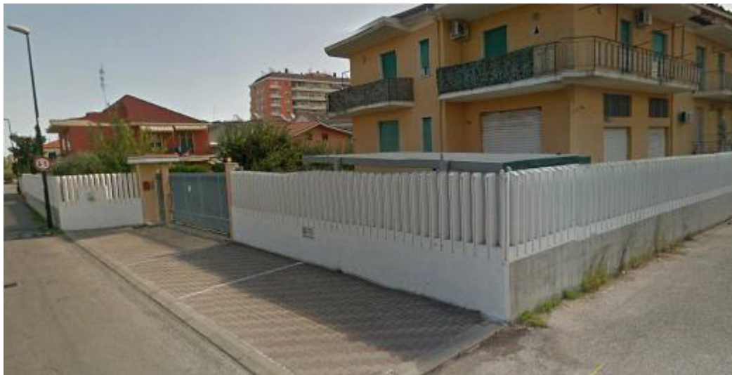
Figura 5– Muro di recinzione fabbricato
