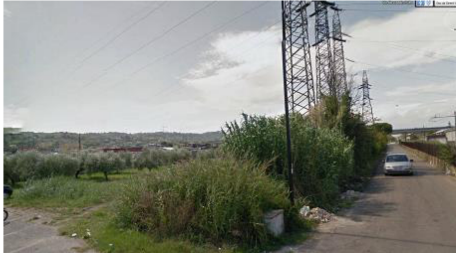
Figura 7- Tralicci alta tensione tra il km 1+600 ed il km 1+750
