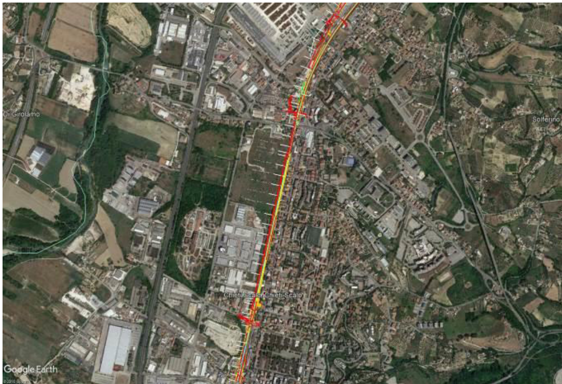
Figura 24 – Raddoppio ferroviario dal km 10+883,350 a fine lotto 2
