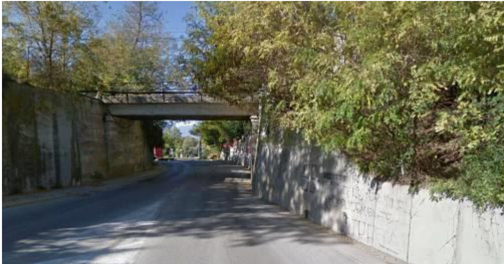
Figura 32 – Ponte attuale su Via Tirino
