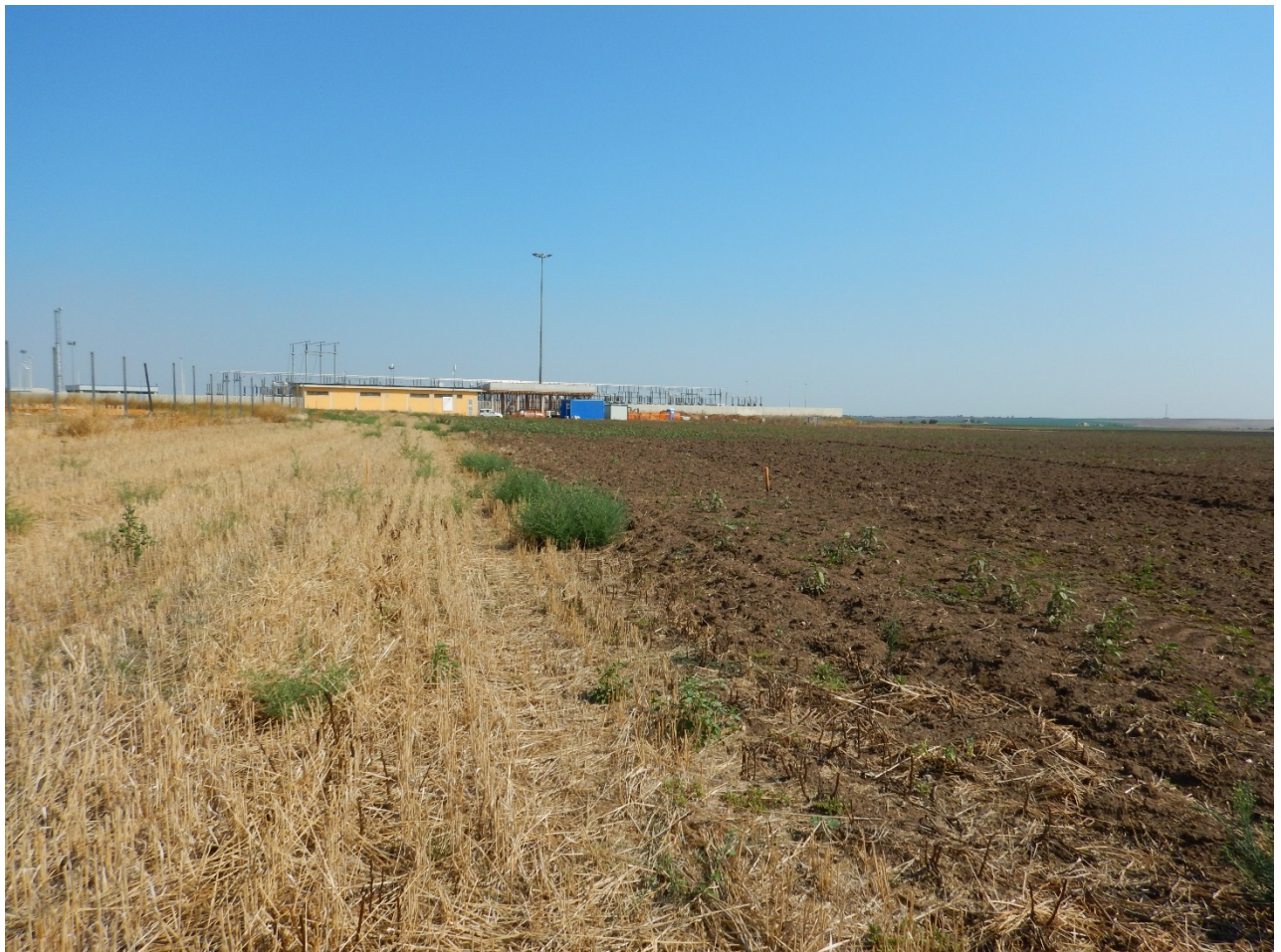
Vista della SE Valle
