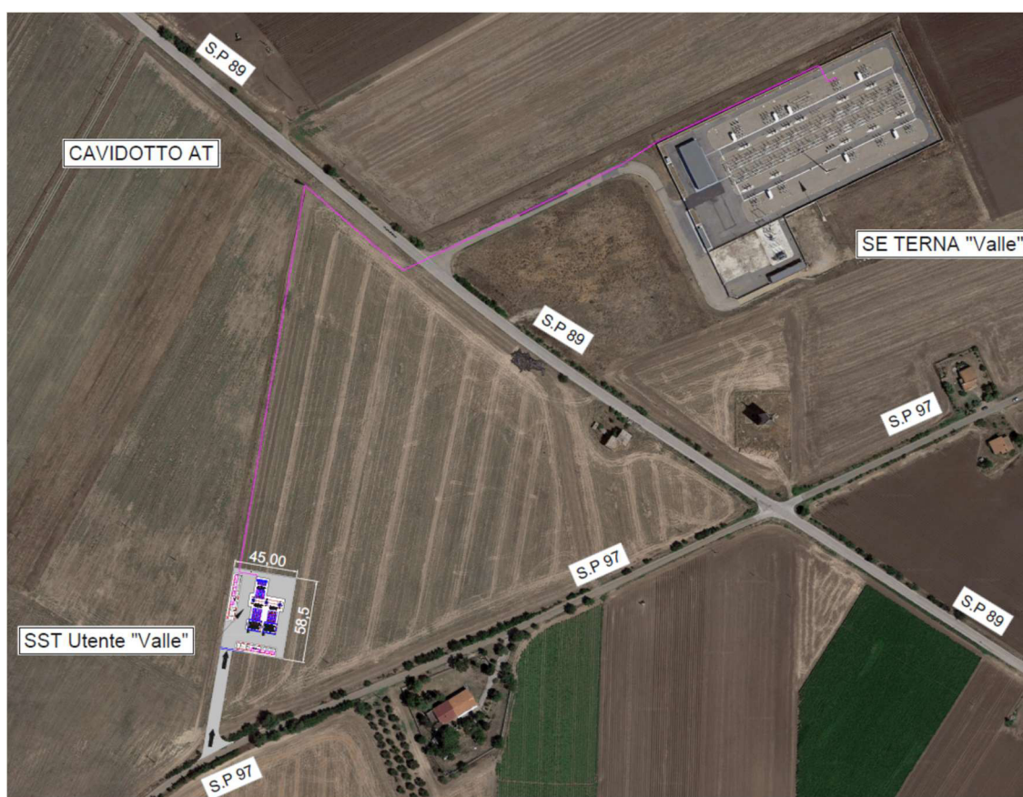
Figura 5 – Tracciato elettrodotto AT di collegamento fra la SST utente e SE Terna
