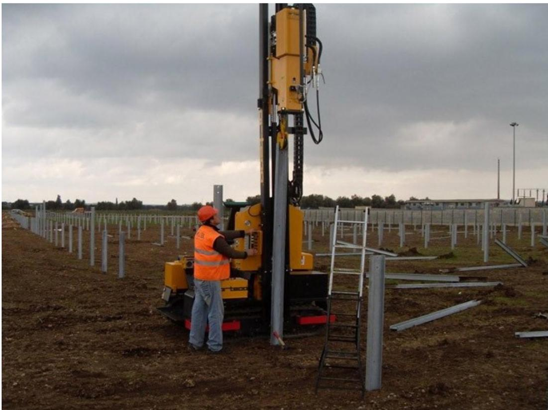
Fig.°22 Operazione di rimozione dei pali infissi
