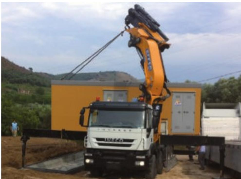
Fig. 23 Operazione di rimozione delle cabine prefabbricate
