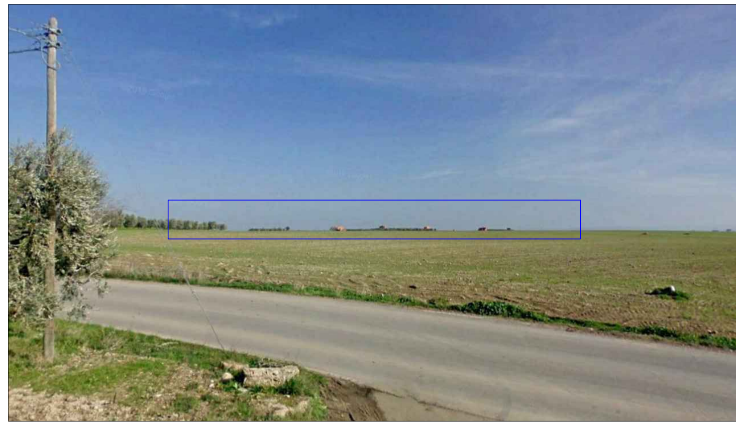
Foto dal punto di presa n°1 ante -operam
