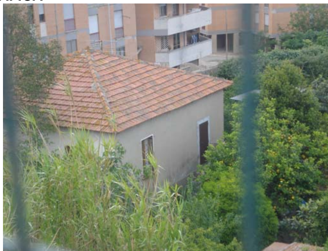
PANORAMICA INTERNA LATERALE SUD-EST
