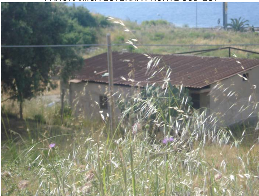
PANORAMICA ESTERNA FRONTE SUD-EST
