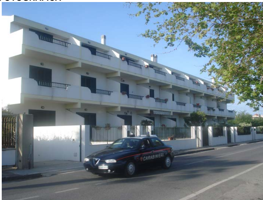
PANORAMICA ESTERNA FRONTE SUD-OVEST
