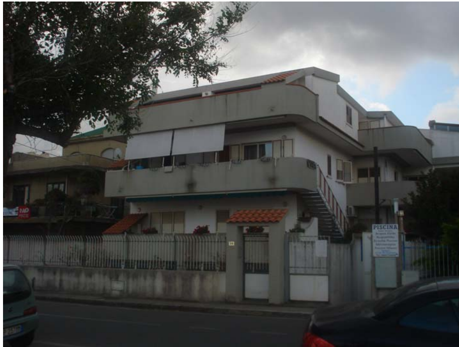
PANORAMICA INTERNA LATERALE NORD EST
