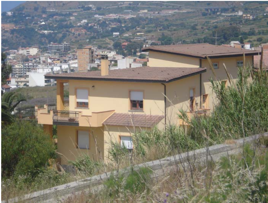
PANORAMICA ESTERNA FRONTE NORD-EST
