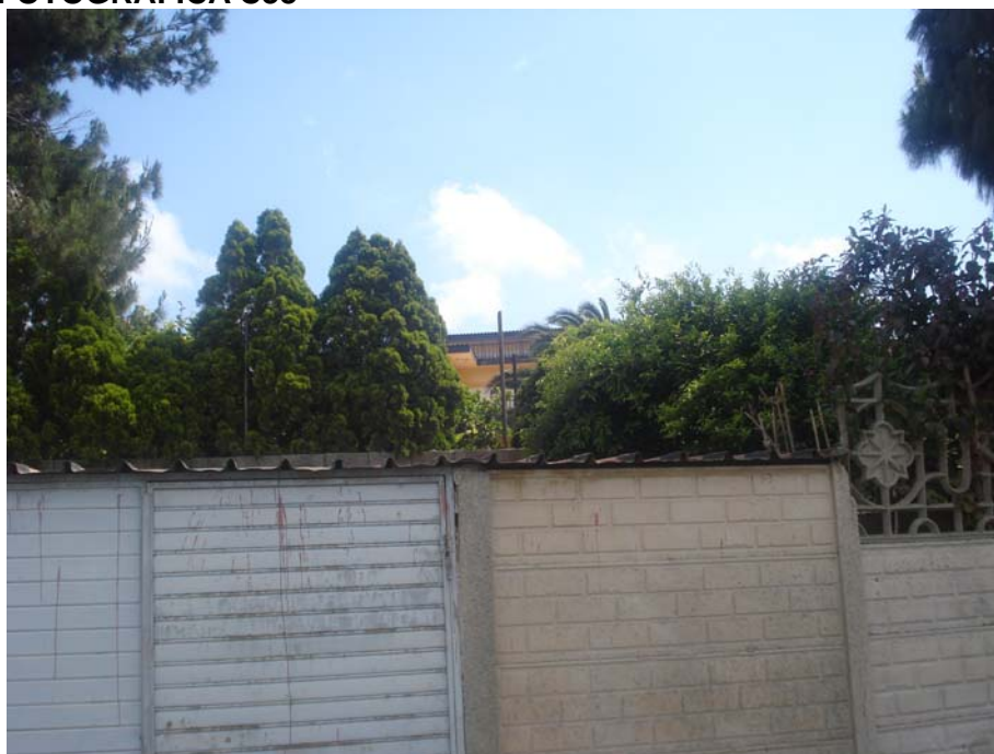
PANORAMICA ESTERNA FRONTE OVEST
