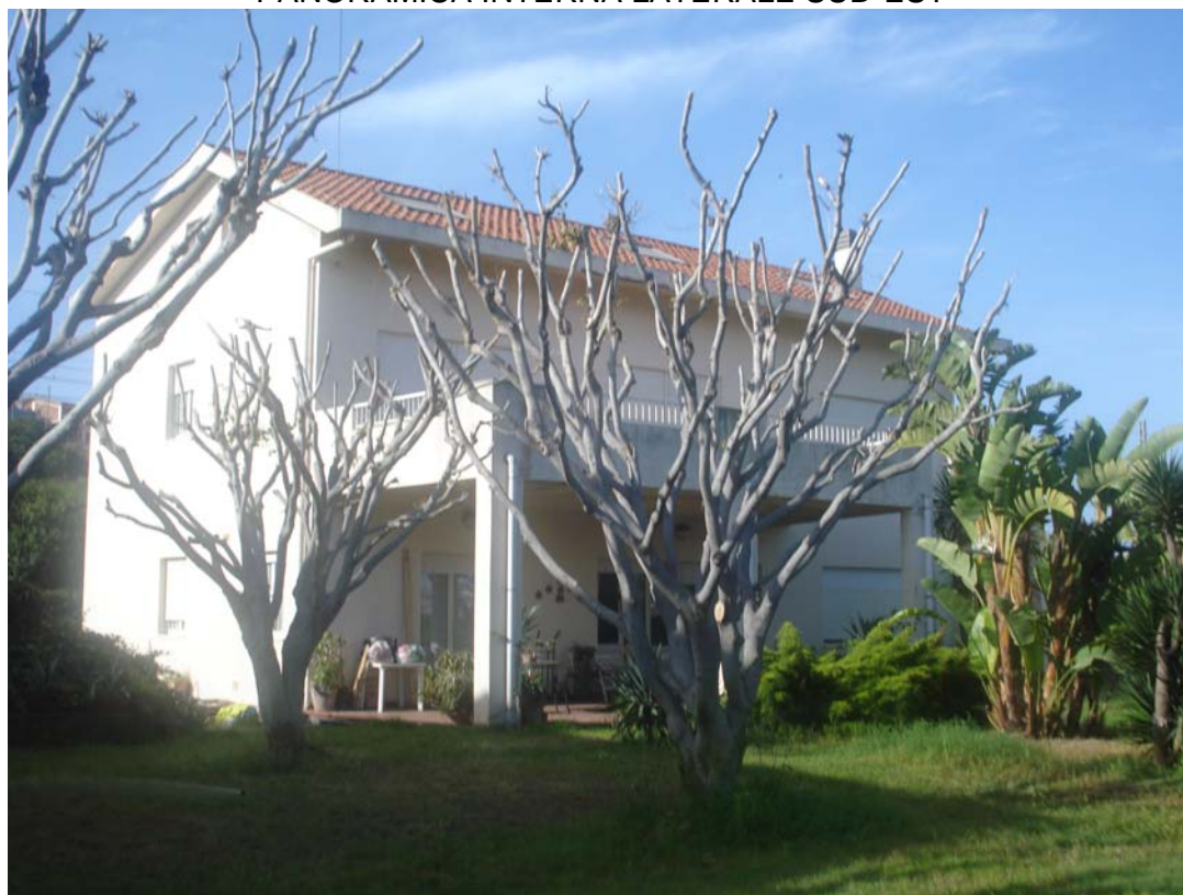
PANORAMICA INTERNA FRONTALE SUD-EST
