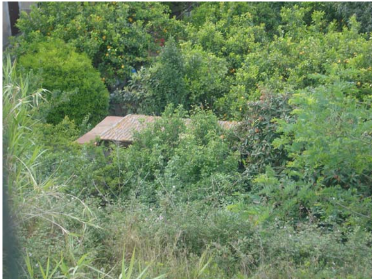
PANORAMICA ESTERNA FRONTE SUD-EST
