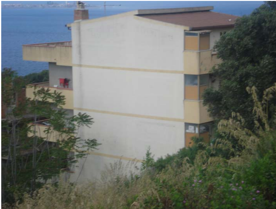
PANORAMICA ESTERNA FRONTE NORD-EST
