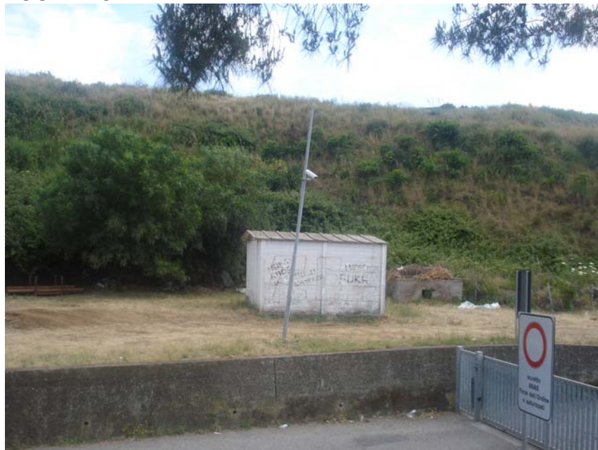
PANORAMICA ESTERNA FRONTE OVEST
