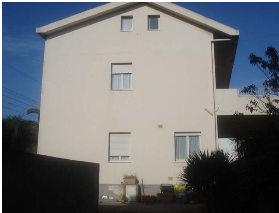
PANORAMICA INTERNA LATERALE SUD-EST
