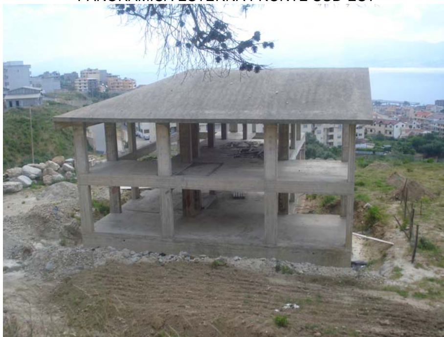
PANORAMICA INTERNA LATERALE SUD
