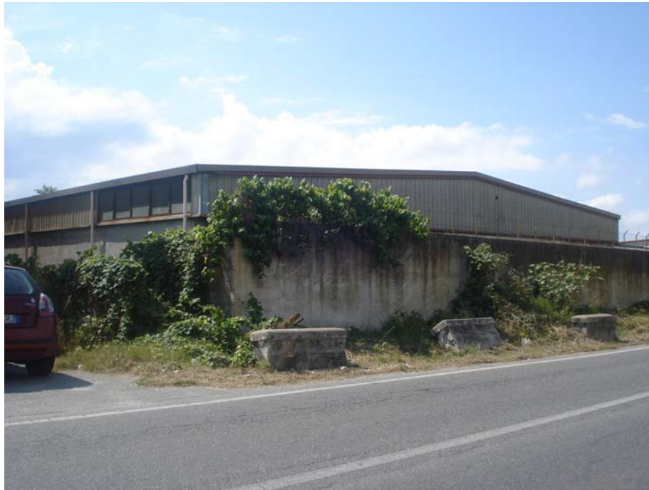
PANORAMICA ESTERNA FRONTE NORD EST
