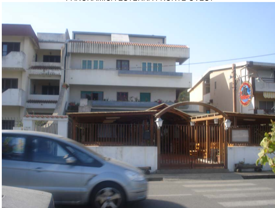
PANORAMICA ESTERNA FRONTE OVEST
