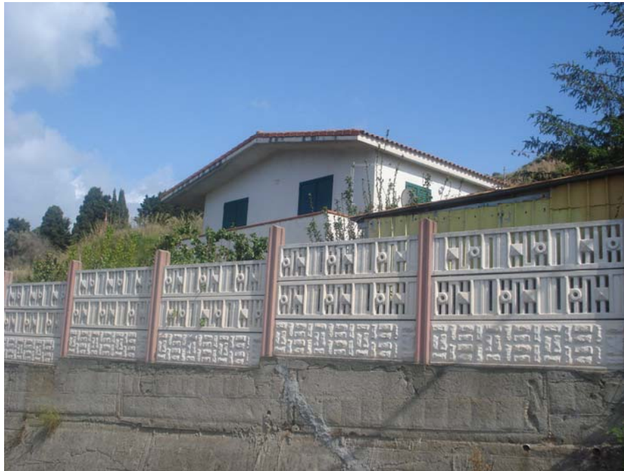
PANORAMICA ESTERNA FRONTE OVEST
