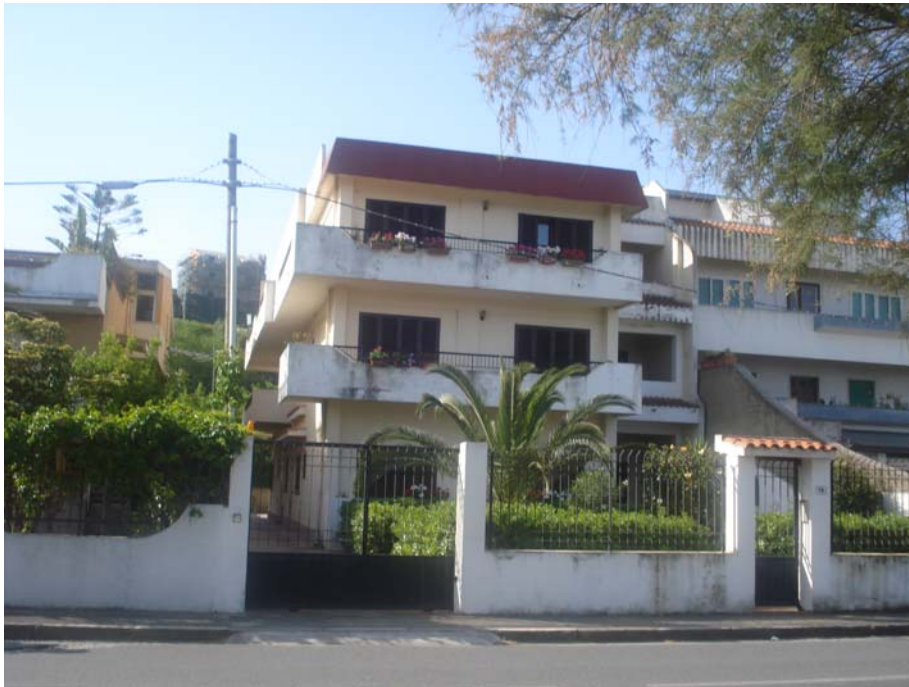
PANORAMICA ESTERNA FRONTE OVEST
