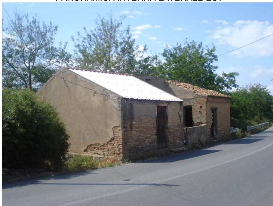
PANORAMICA INTERNA FRONTALE NORD-EST
