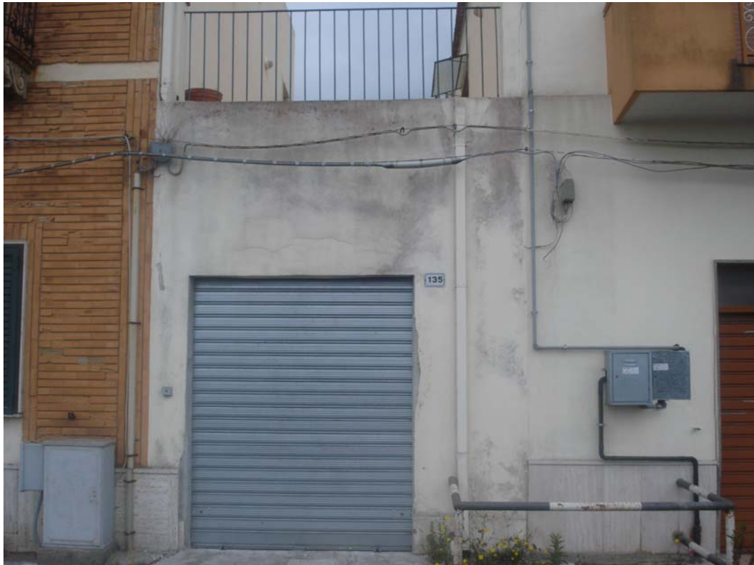
PANORAMICA ESTERNA FRONTE OVEST
