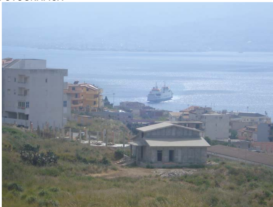
PANORAMICA ESTERNA FRONTE SUD-EST
