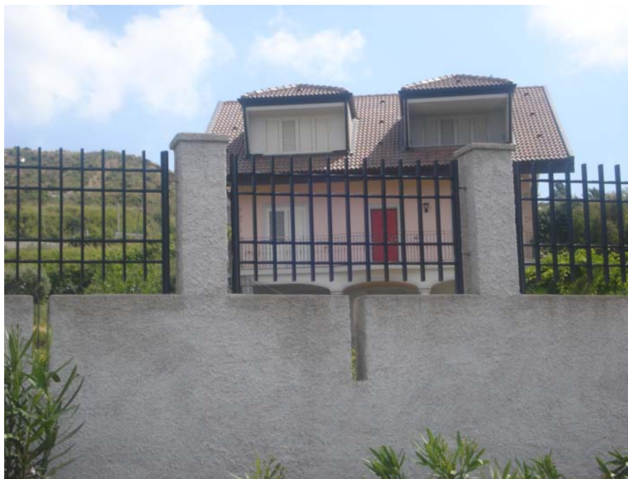
PANORAMICA INTERNA FRONTALE OVEST
