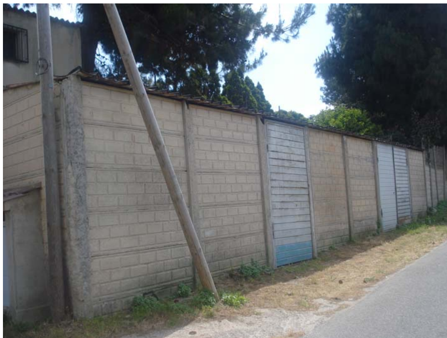
PANORAMICA ESTERNA FRONTE SUD-OVEST
