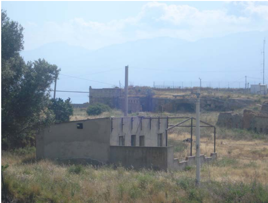
PANORAMICA ESTERNA FRONTE SUD-EST
