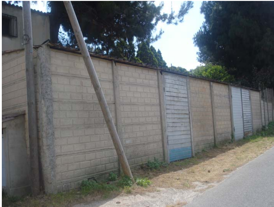
PANORAMICA ESTERNA FRONTE SUD-OVEST
