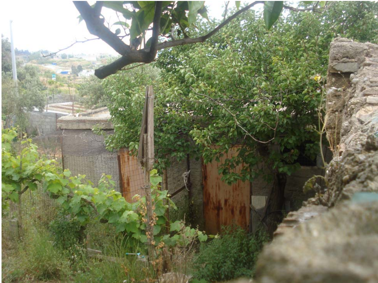
PANORAMICA ESTERNA FRONTE SUD-EST
