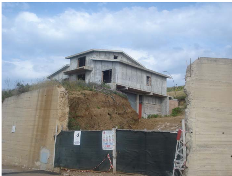
PANORAMICA ESTERNA FRONTE NORD-OVEST
