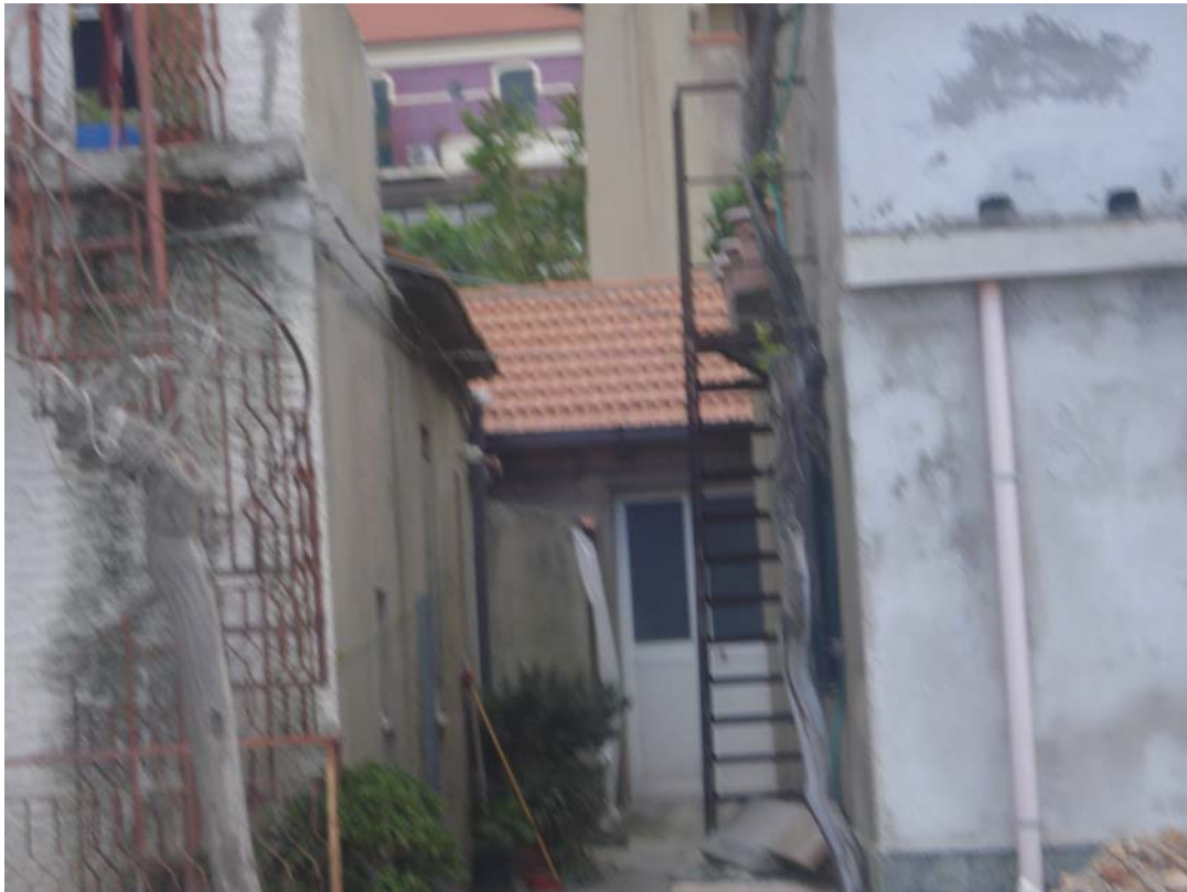
PANORAMICA ESTERNA FRONTE OVEST
