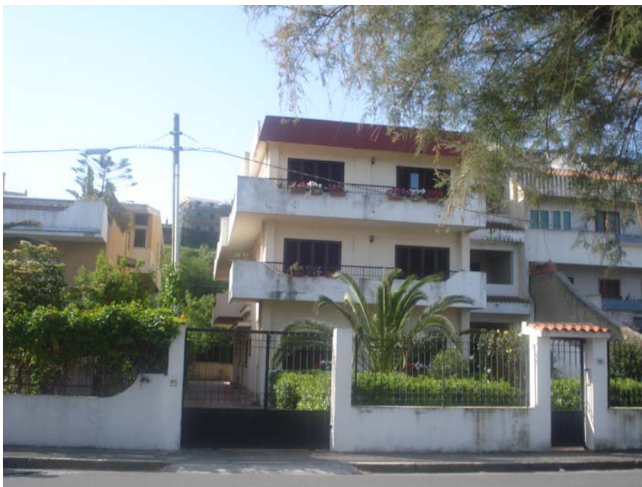
PANORAMICA ESTERNA FRONTE OVEST
