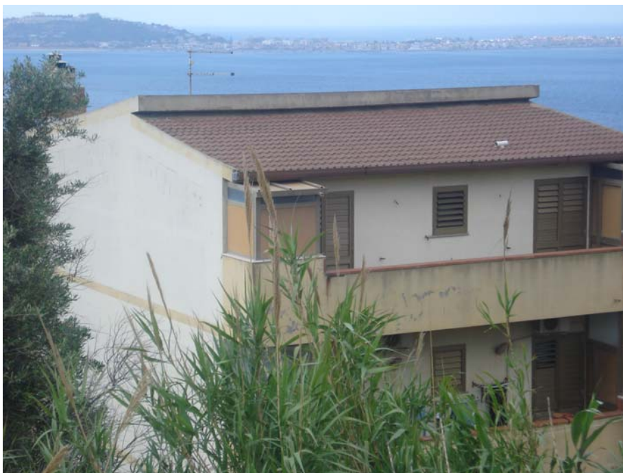
PANORAMICA INTERNA LATERALE SUD-EST
