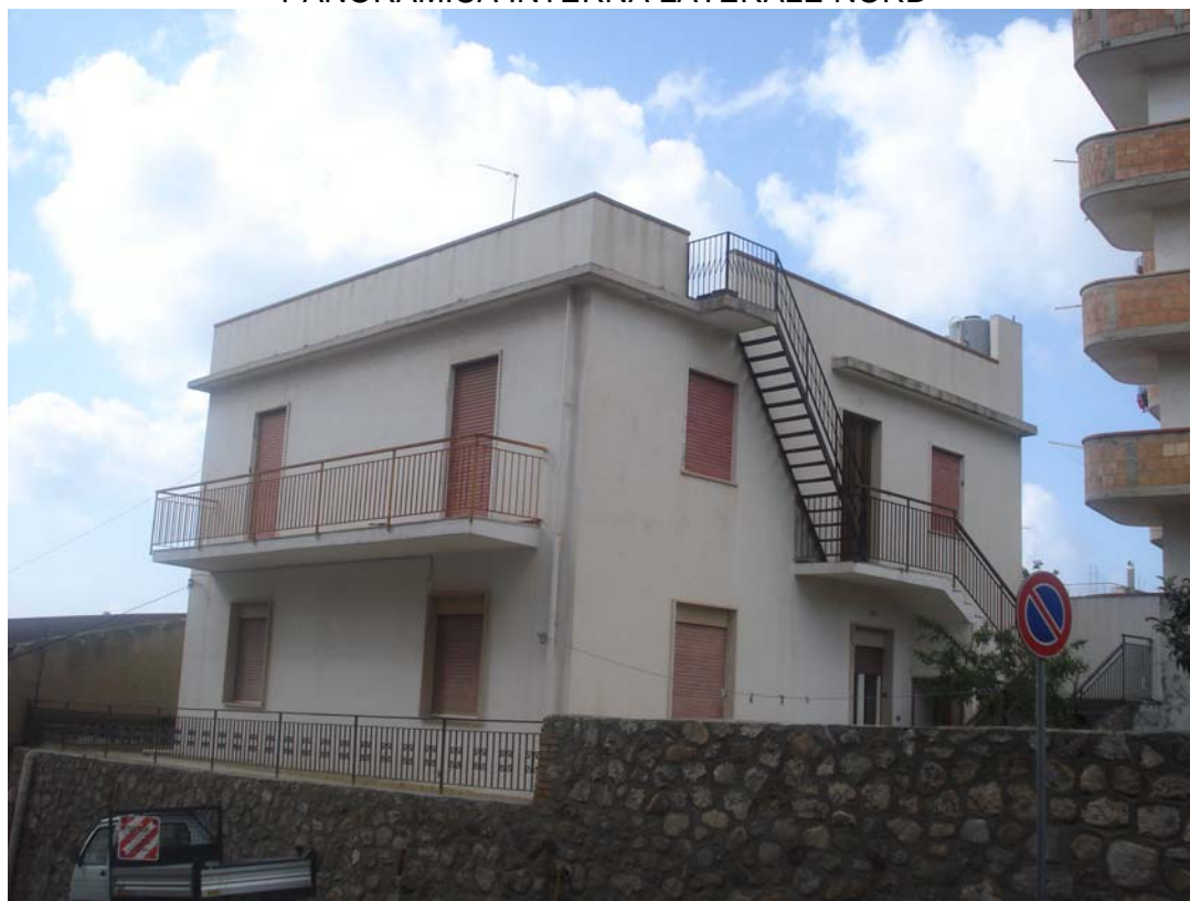
PANORAMICA INTERNA FRONTALE NORD-EST
