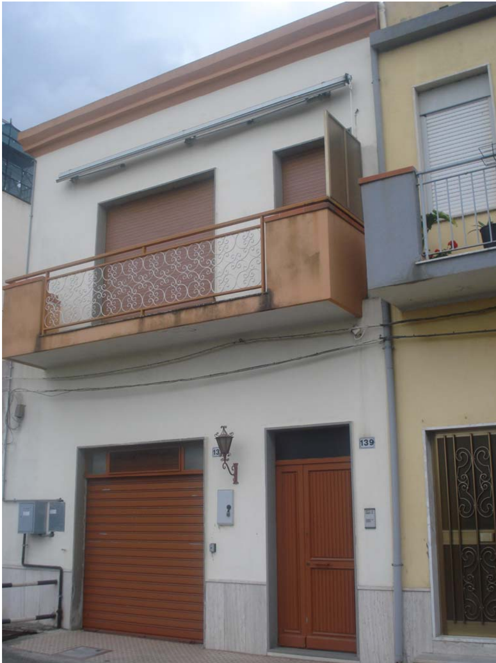
PANORAMICA ESTERNA FRONTE OVEST
