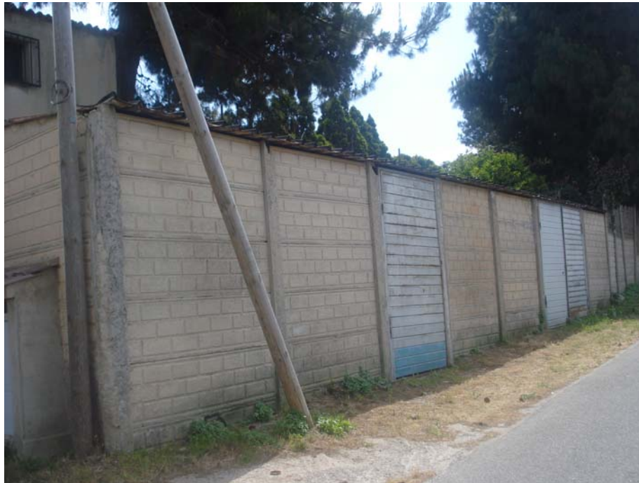
PANORAMICA ESTERNA FRONTE SUD-OVEST
