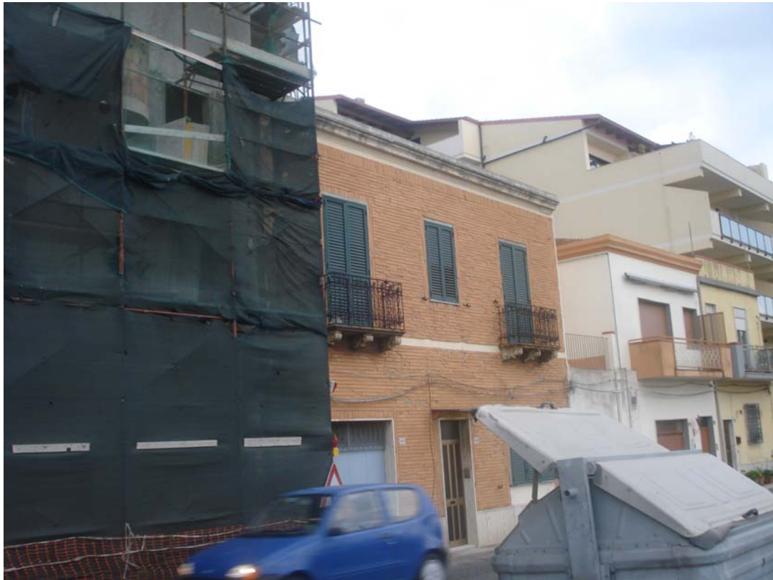
PANORAMICA ESTERNA FRONTE SUD-OVEST
