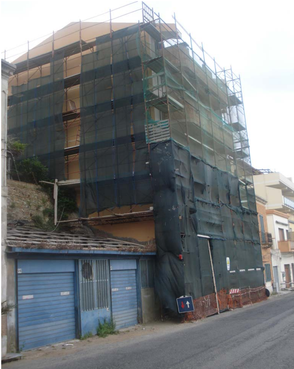
PANORAMICA ESTERNA FRONTE SUD-EST
