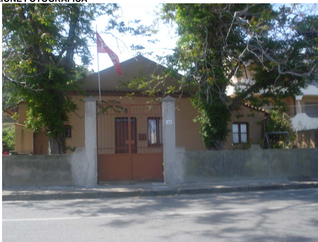
PANORAMICA ESTERNA FRONTE OVEST
