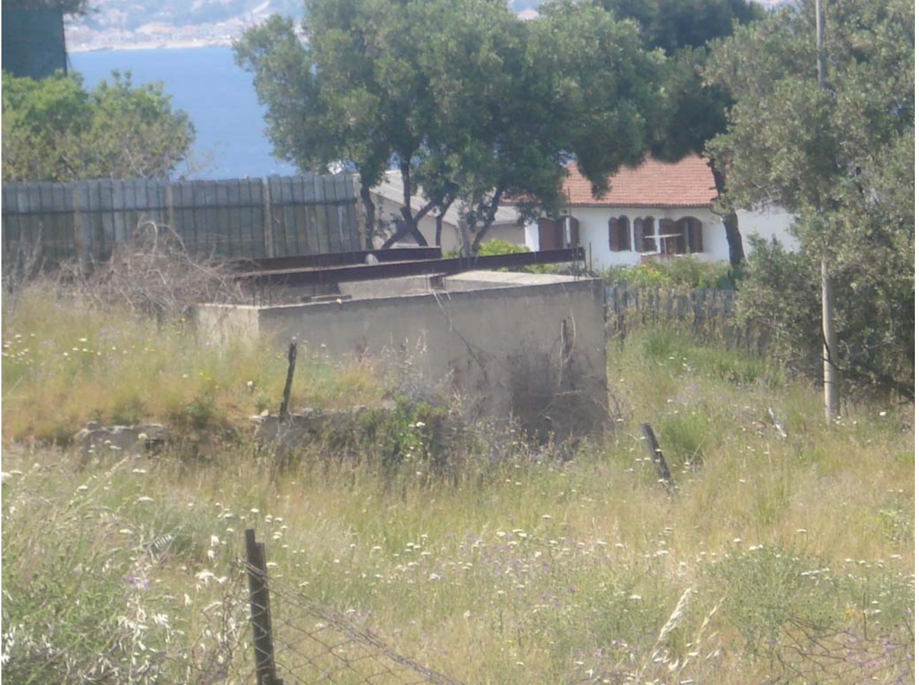
PANORAMICA ESTERNA FRONTE SUD-EST
