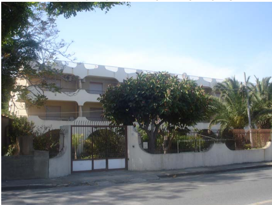
PANORAMICA INTERNA LATERALE SUD-OVEST
