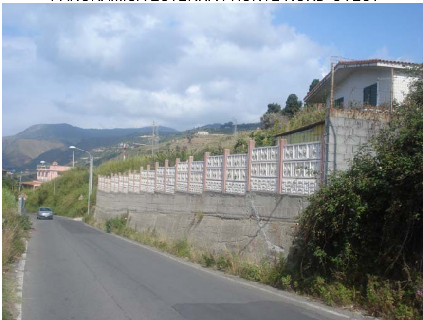
PANORAMICA ESTERNA FRONTE NORD-OVEST
