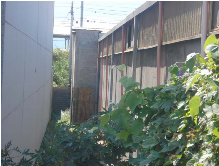
PANORAMICA ESTERNA FRONTE OVEST
