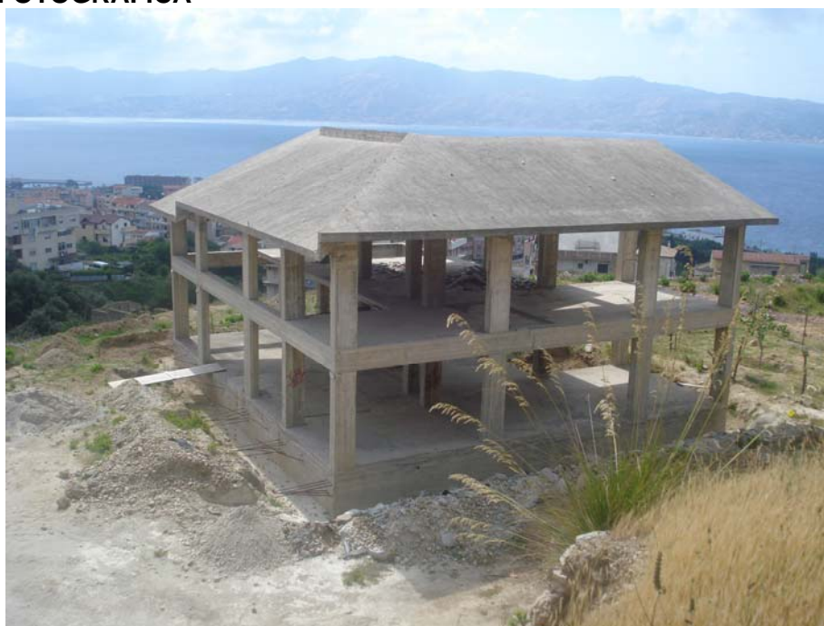
PANORAMICA ESTERNA FRONTE SUD-EST
