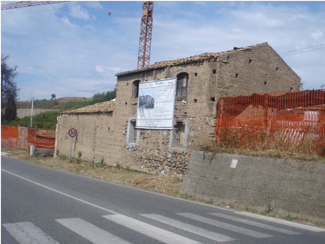
PANORAMICA ESTERNA FRONTE NORD-OVEST
