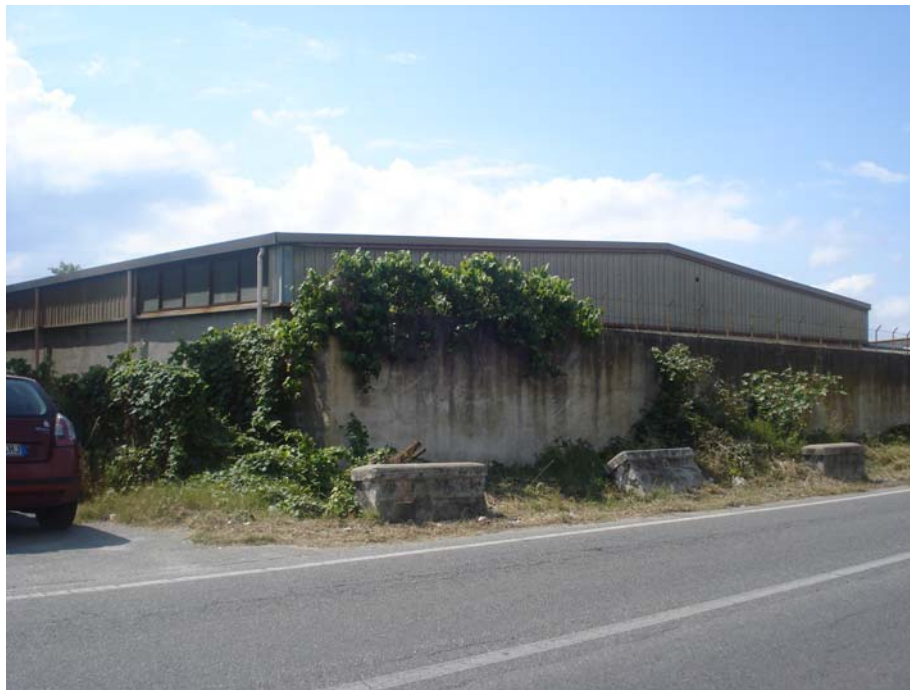
PANORAMICA ESTERNA FRONTE NORD EST
