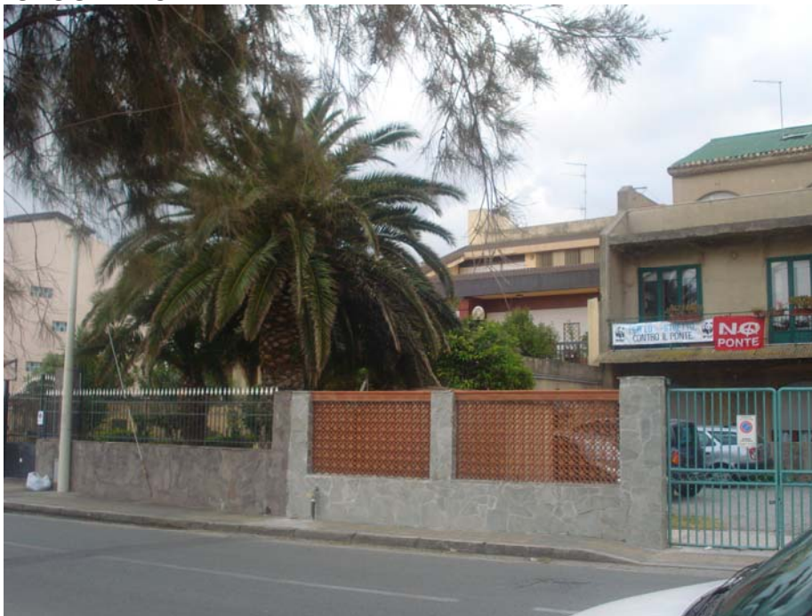
PANORAMICA ESTERNA FRONTE NORD-OVEST
