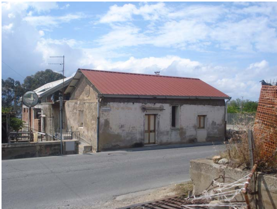
PANORAMICA ESTERNA FRONTE EST
