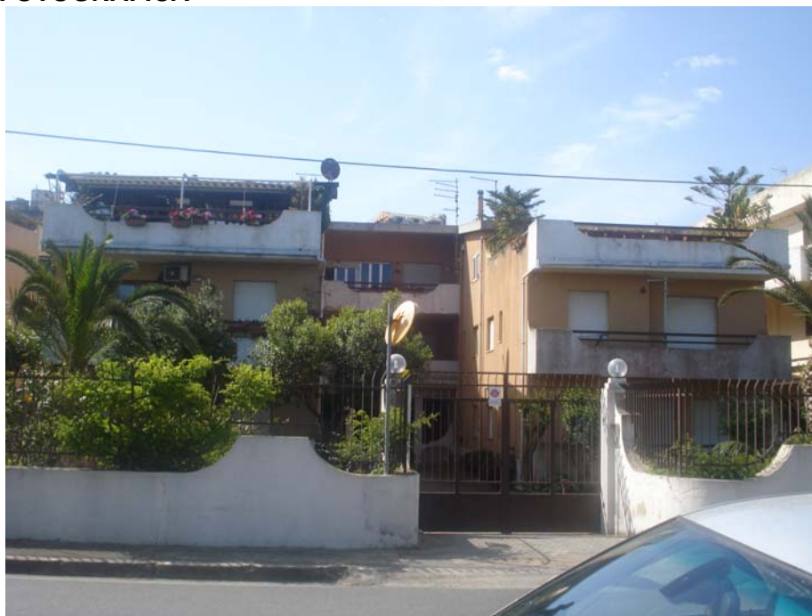
PANORAMICA ESTERNA FRONTE EST
