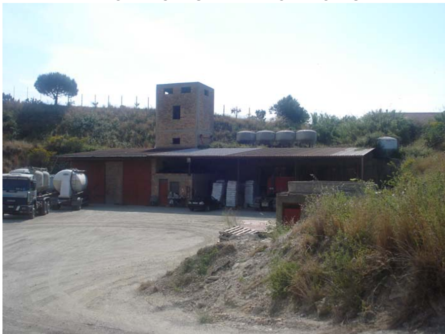
PANORAMICA ESTERNA FRONTE OVEST
