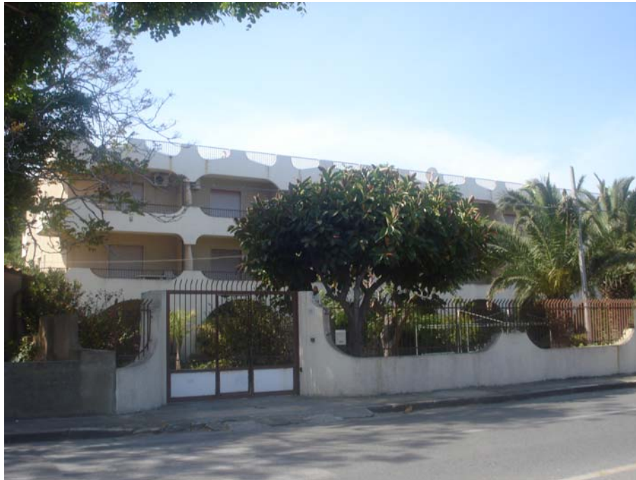
PANORAMICA INTERNA LATERALE SUD-OVEST
