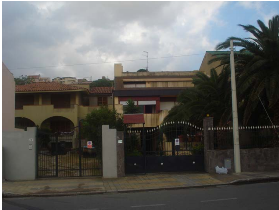
PANORAMICA ESTERNA FRONTE OVEST
