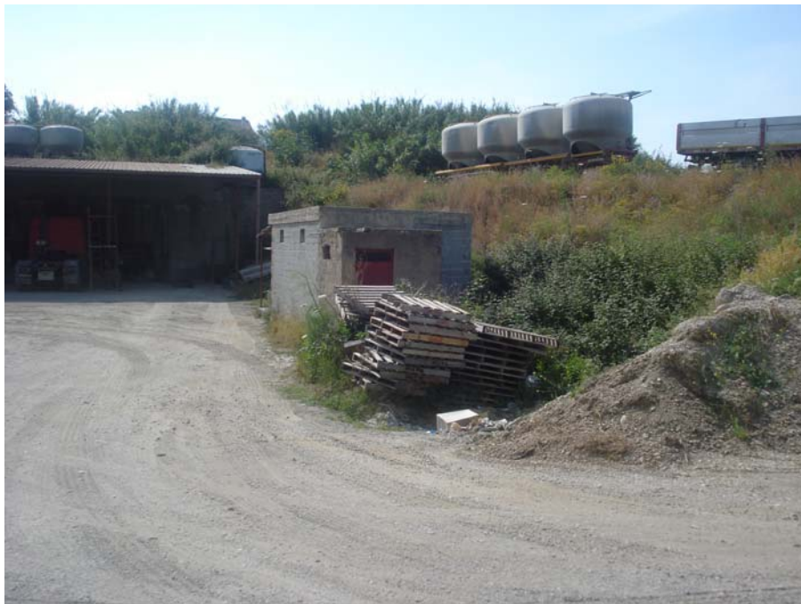
PANORAMICA ESTERNA FRONTE OVEST
