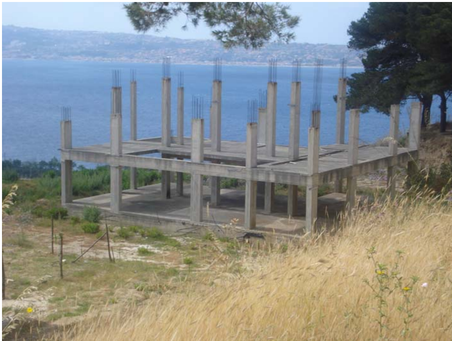
PANORAMICA ESTERNA FRONTE EST
