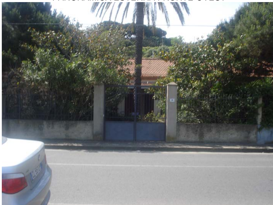
PANORAMICA ESTERNA FRONTE OVEST
