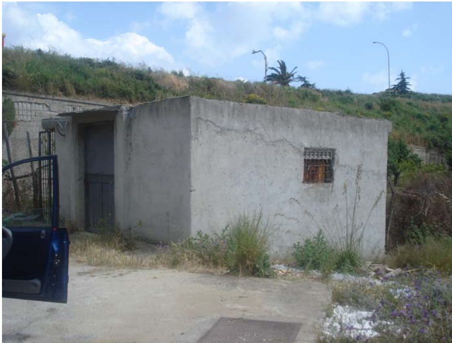
PANORAMICA ESTERNA FRONTE SUD-OVEST
