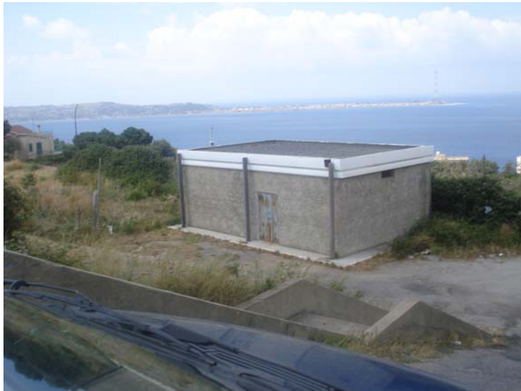
PANORAMICA ESTERNA FRONTE SUD-EST
