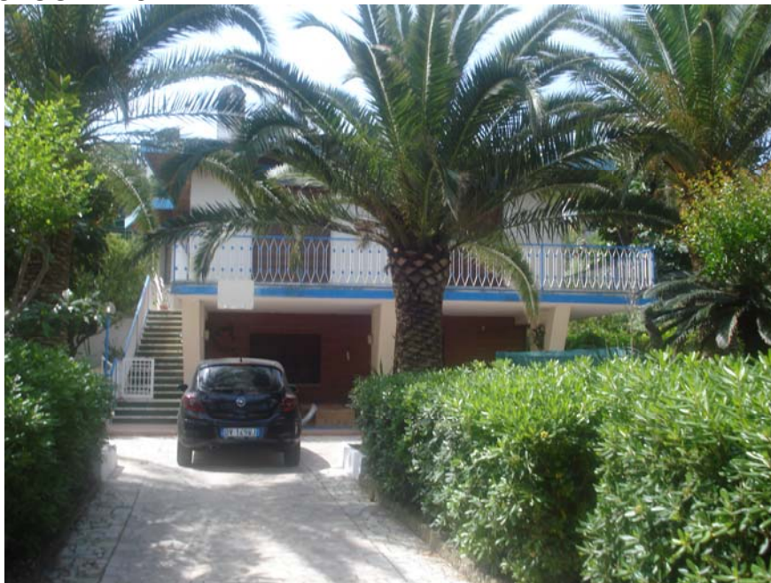
PANORAMICA ESTERNA FRONTE OVEST
