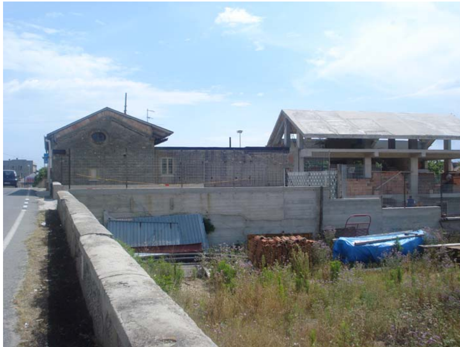
PANORAMICA ESTERNA FRONTE SUD-EST
