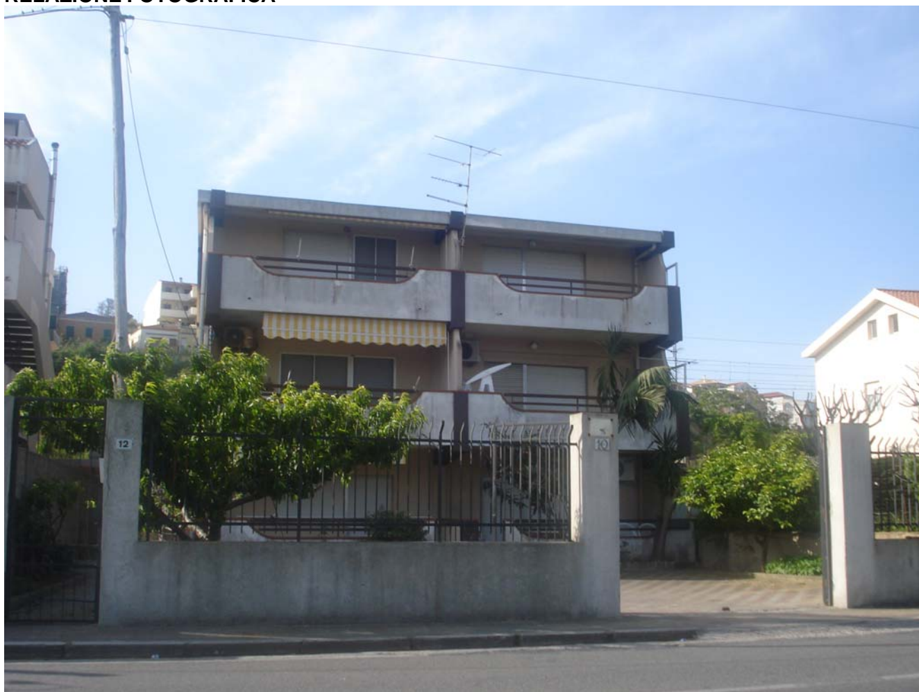
PANORAMICA ESTERNA FRONTE OVEST
