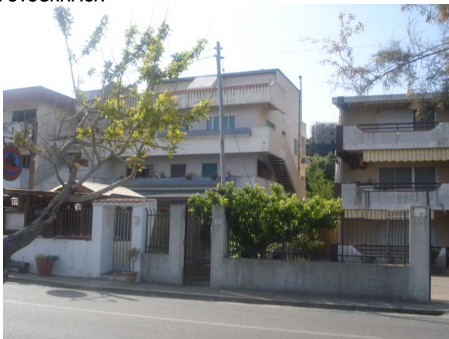
PANORAMICA ESTERNA FRONTE OVEST
