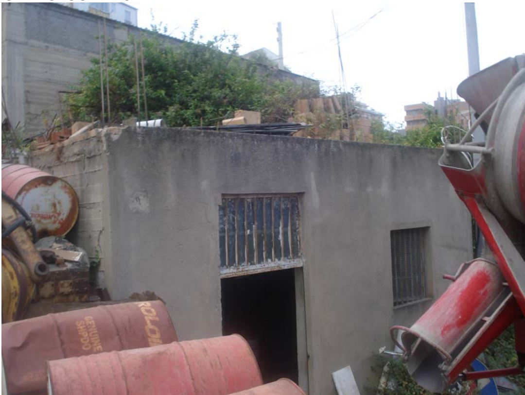
PANORAMICA ESTERNA FRONTE OVEST
