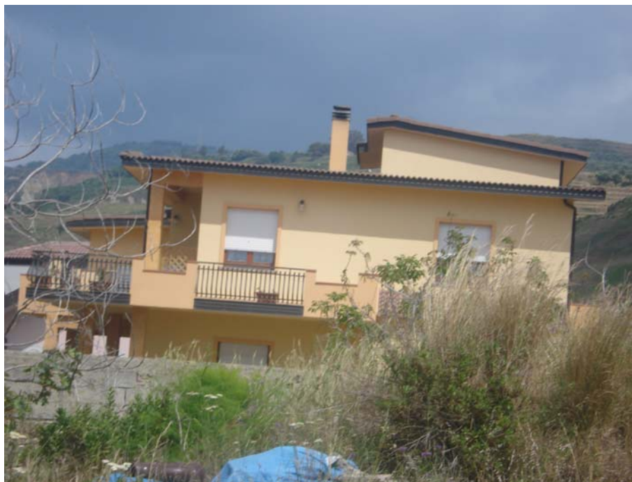
PANORAMICA INTERNA FRONTALE NORD –EST
