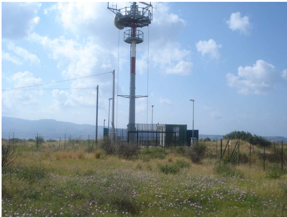
PANORAMICA ESTERNA FRONTE NORD-EST
