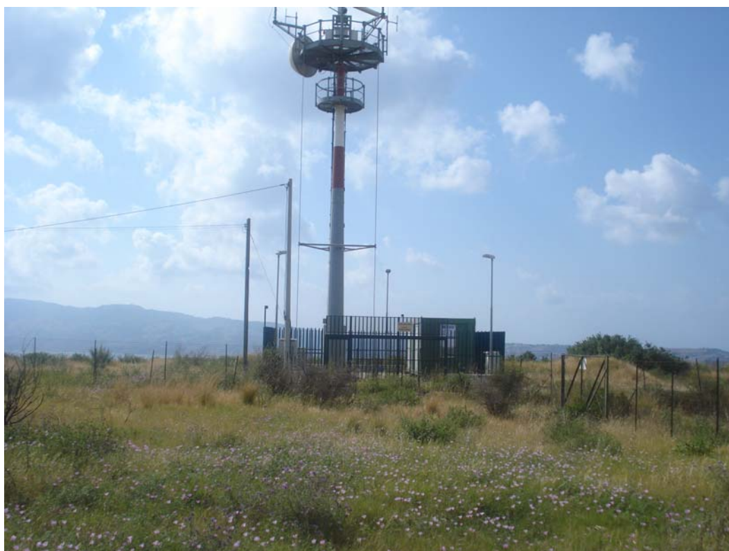
PANORAMICA ESTERNA FRONTE NORD-EST
