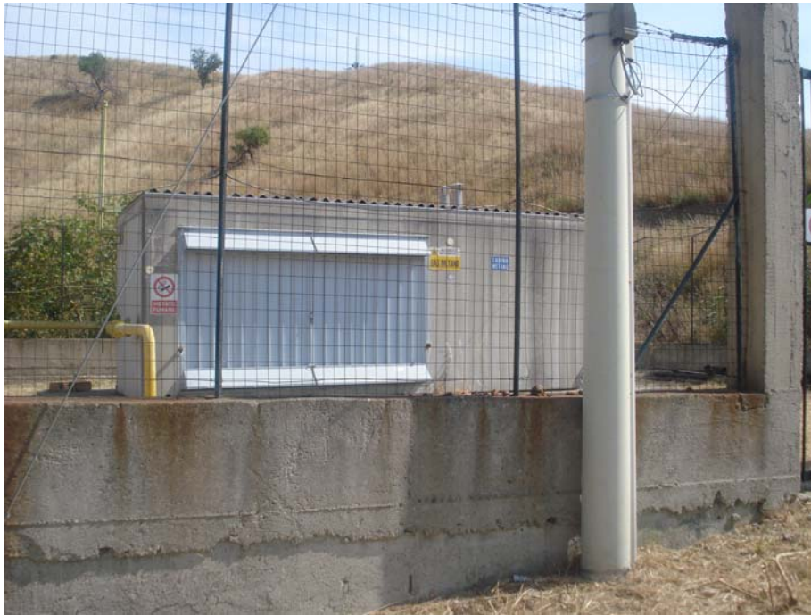
PANORAMICA ESTERNA FRONTE OVEST
