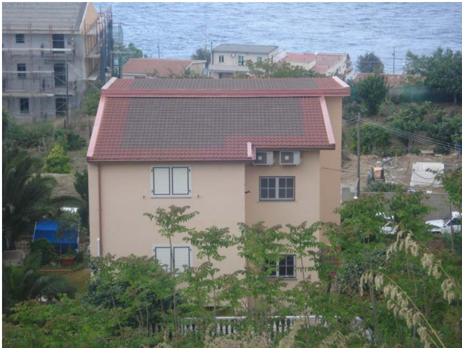
PANORAMICA ESTERNA FRONTE EST
