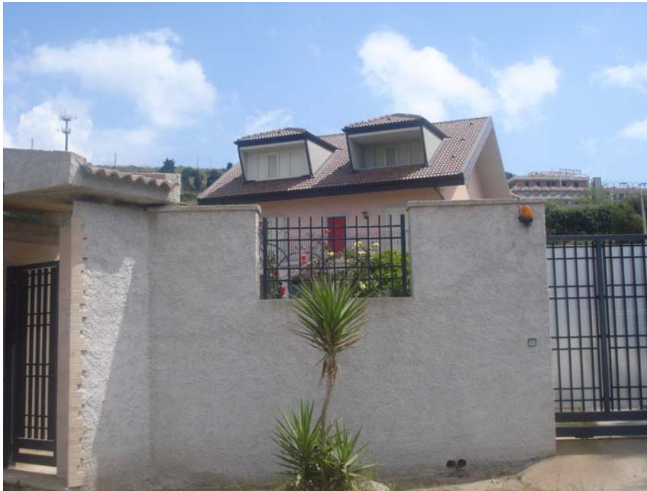
PANORAMICA ESTERNA FRONTE SUD-OVEST
