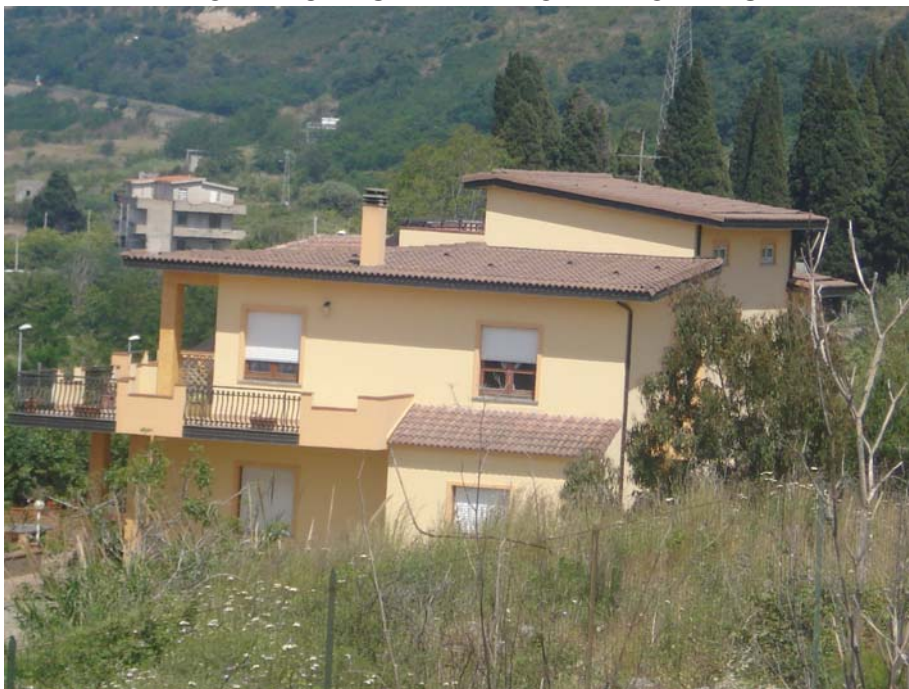
PANORAMICA INTERNA LATERALE NORD-EST
