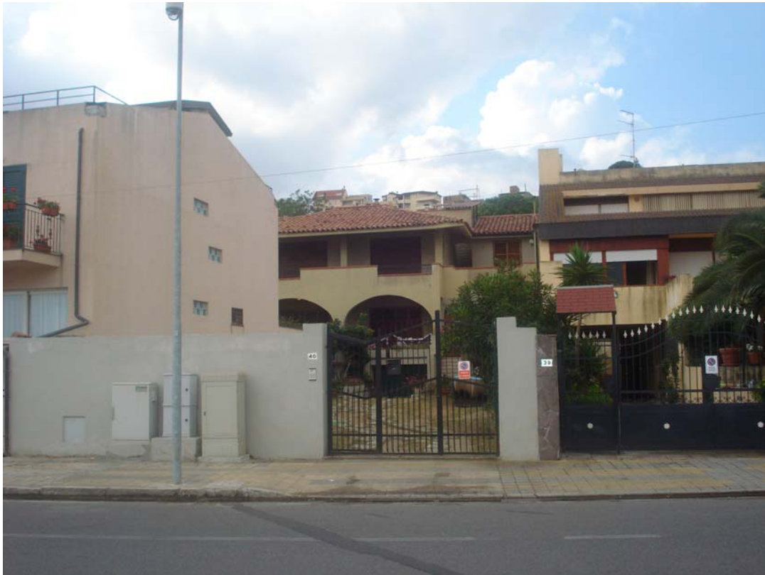
PANORAMICA ESTERNA FRONTE OVEST
