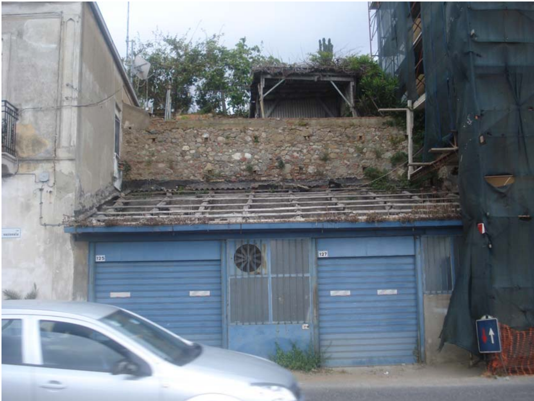
PANORAMICA ESTERNA FRONTE OVEST
