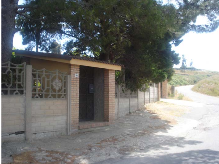
PANORAMICA ESTERNA FRONTE SUD-OVEST
