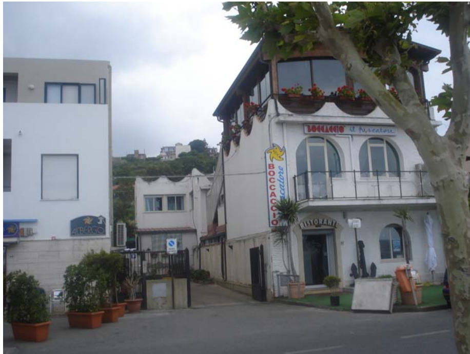
PANORAMICA ESTERNA FRONTE OVEST
