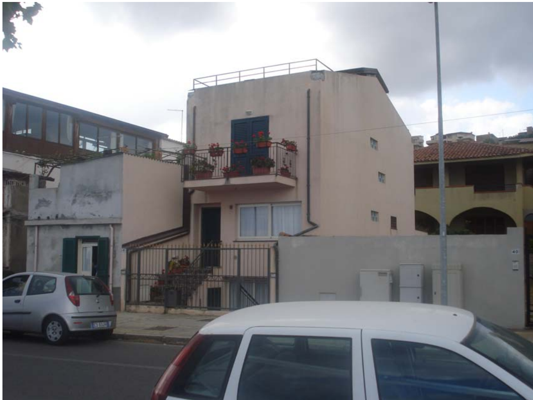
PANORAMICA ESTERNA FRONTE OVEST
