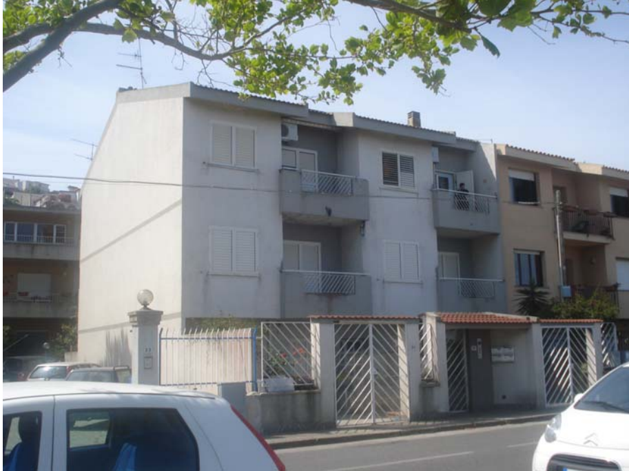
PANORAMICA ESTERNA FRONTE SUD-OVEST
