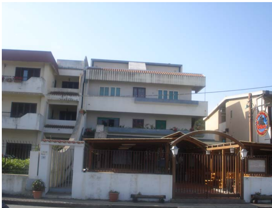
PANORAMICA ESTERNA FRONTE OVEST
