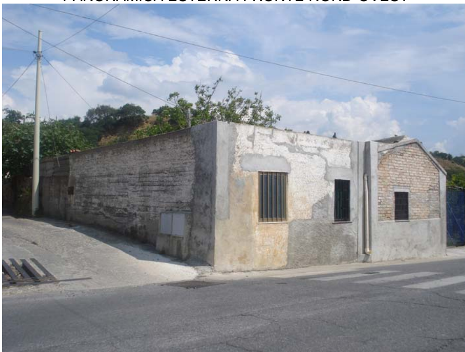
PANORAMICA ESTERNA FRONTE SUD-OVEST
