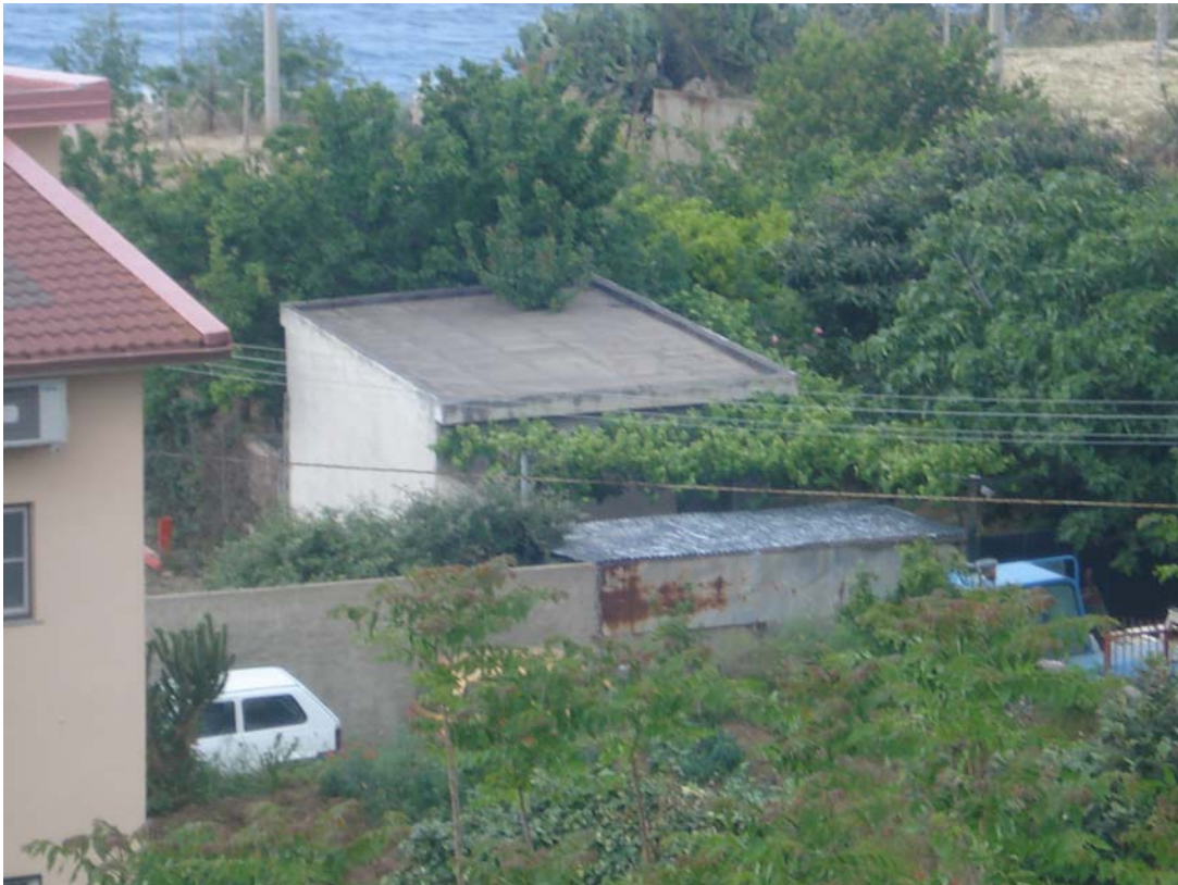
PANORAMICA ESTERNA FRONTE NORD-OVEST
