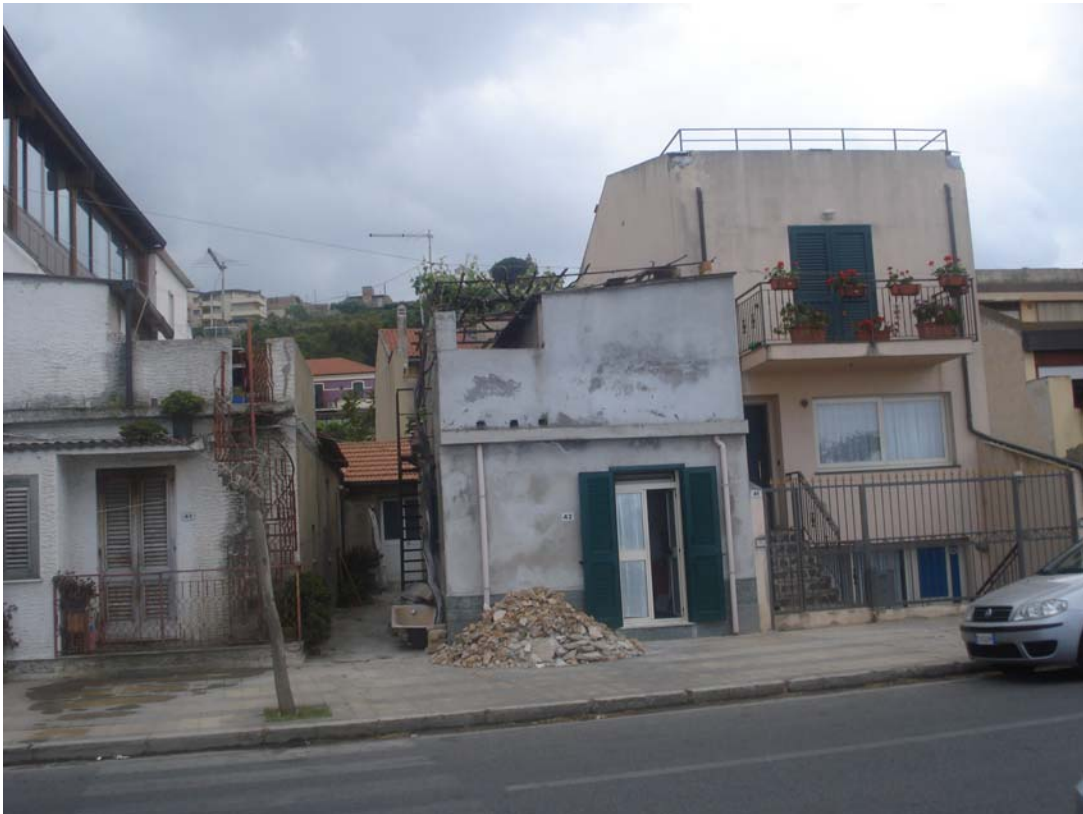
PANORAMICA ESTERNA FRONTE OVEST
