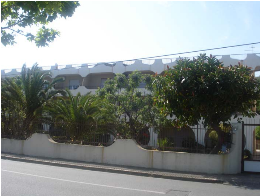
PANORAMICA ESTERNA FRONTE NORD-OVEST
