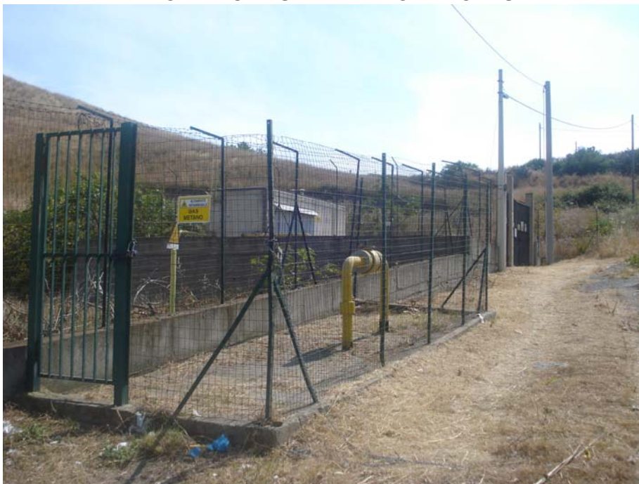
PANORAMICA ESTERNA FRONTE SUD-OVEST
