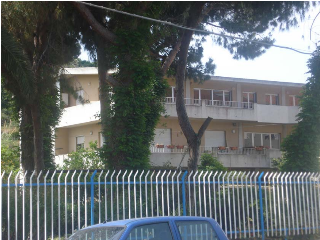
PANORAMICA ESTERNA FRONTE SUD-OVEST
