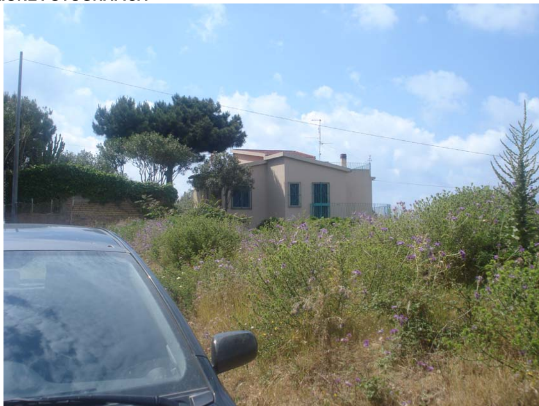
PANORAMICA ESTERNA FRONTE SUD-OVEST
