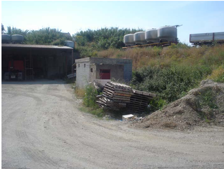
PANORAMICA ESTERNA FRONTE OVEST
