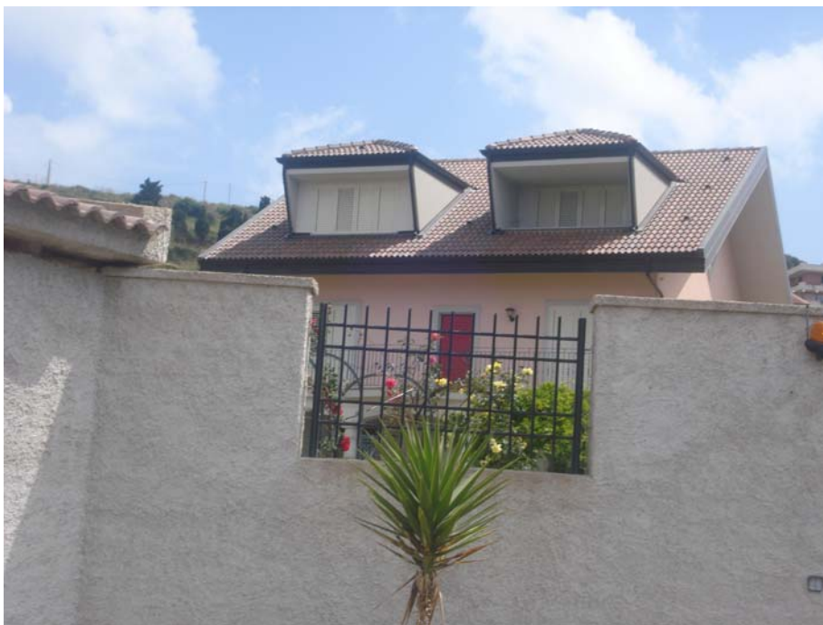
PANORAMICA INTERNA LATERALE SUD-OVEST
