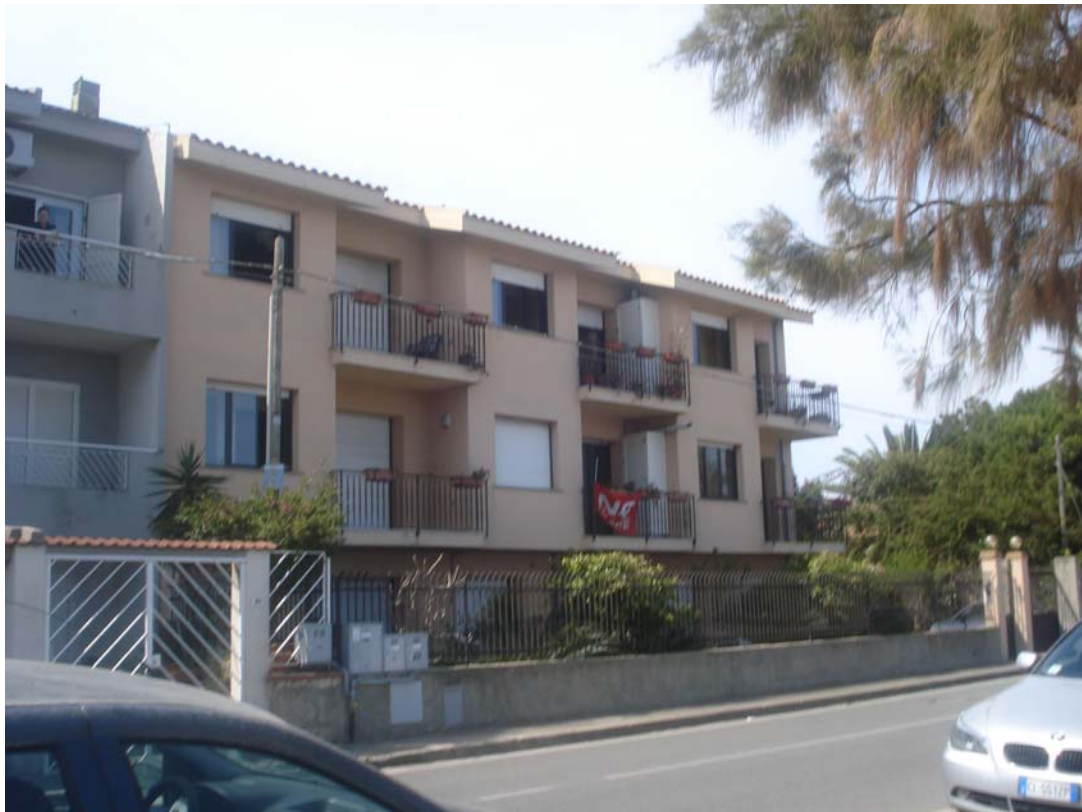
PANORAMICA ESTERNA FRONTE SUD-OVEST
