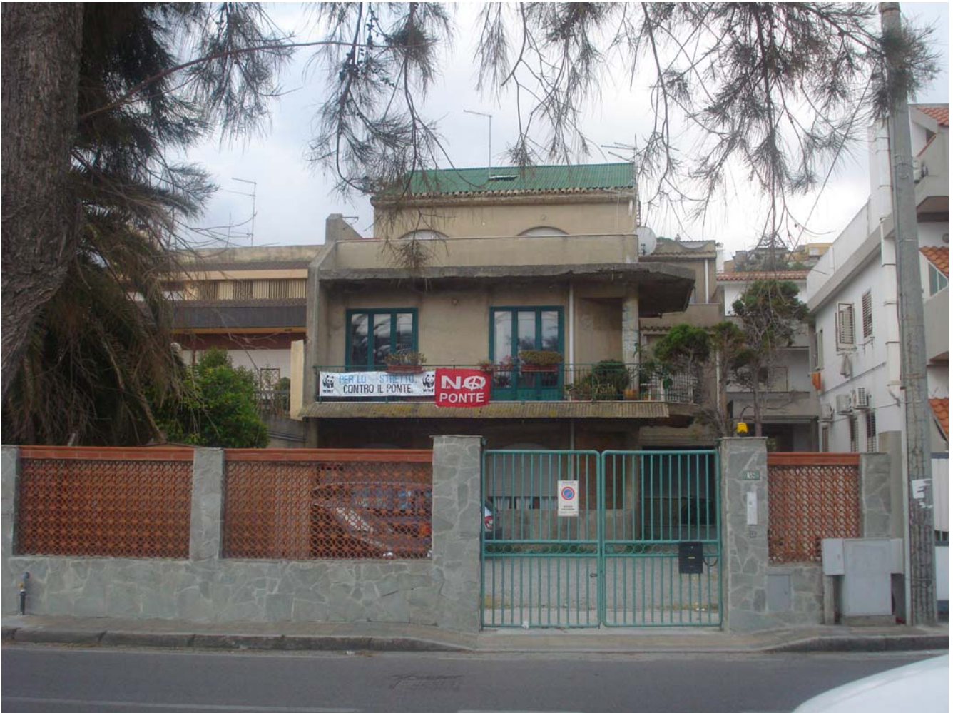
PANORAMICA ESTERNA FRONTE OVEST
