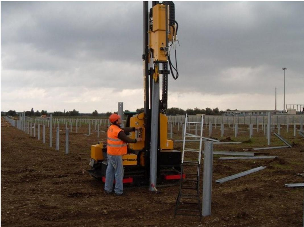
Fig. n°1 Operazione di rimozione dei pali infissi
