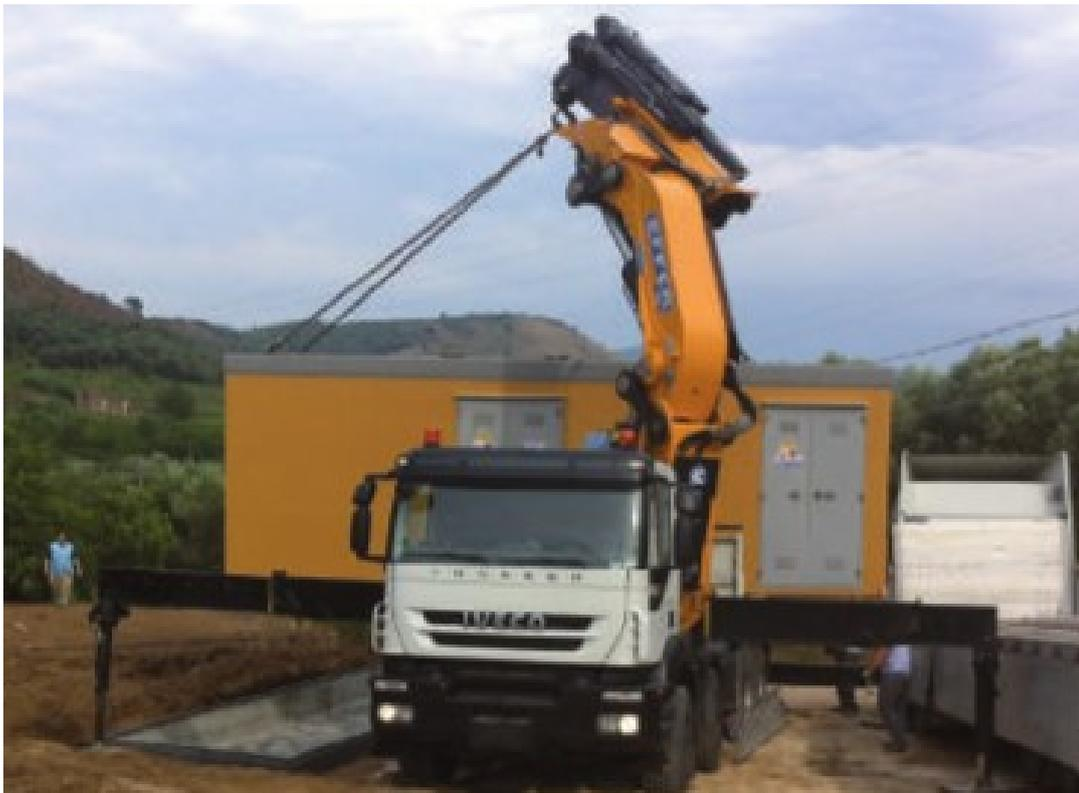
Fig. n°2 Operazione di rimozione delle cabine prefabbricate
