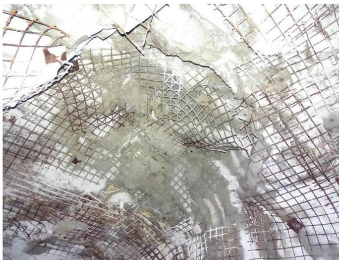
**Figura 6.5 - Particolare della zona interessata dai crolli in calotta, trattata con la posa della rete elettrosaldata, chiodature e spritz beton.**
