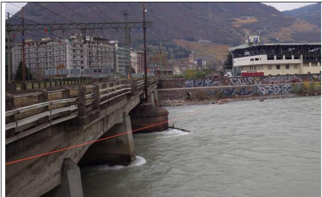
Fig. 6 – Fase di installazione del sistema di sospensione del cavo elettrico multipolare tramite fune sintetica
