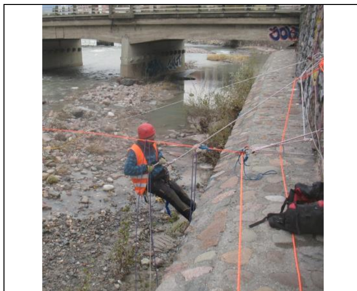
Fig. 7 – Particolare del sistema di ancoraggio in sponda destra del fiume
