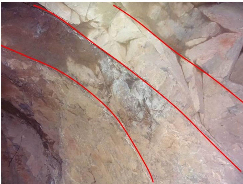
Figura 25. Esempio di piani subverticali identificati nel tratto iniziale del cunicolo.
