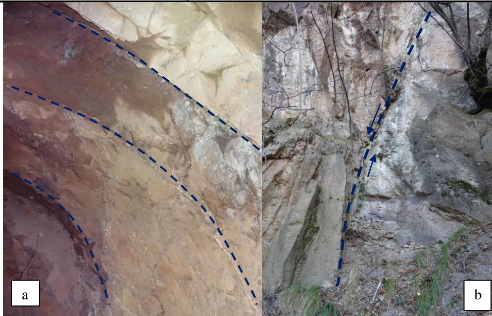
Figura 15. Esempio di strutture S2 ad alto angolo all'interno del cunicolo con presenza di mineralizzazione a calcite (a) e sul lato nord del Virgolo, con damage zone e mineralizzazione a calcite (b).
