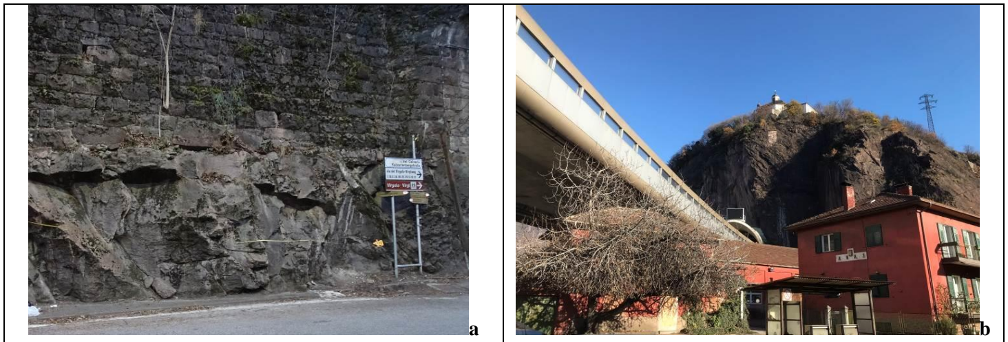
Figura 20. Affioramenti di IGR in prossimità dell'imbocco Nord del tunnel in progetto (a); parete massiva a monte dell'imbocco del tunnel autostradale del Virgolo (b).
