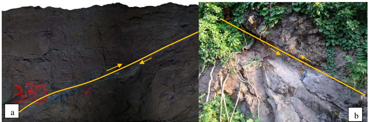
Figura 16. Esempio di strutture S3 a medio angolo all'interno del cunicolo (a) e nel corrispondente tratto esterno tra la prima e la seconda cappella di Via del Calvario (b).
