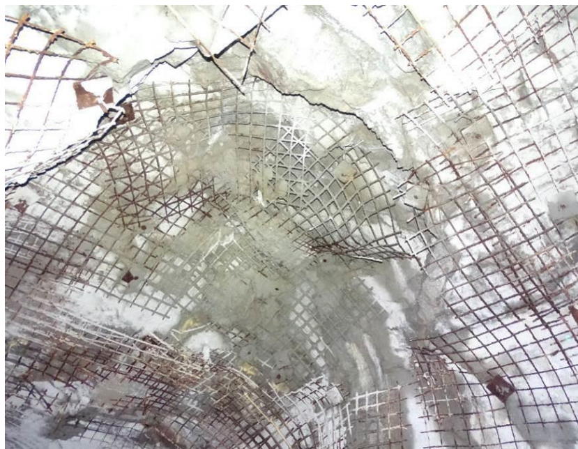
Figura 30. Particolare della zona interessata dai crolli in calotta, trattata con la posa della rete elettrosaldata, chiodature e spritz beton.
