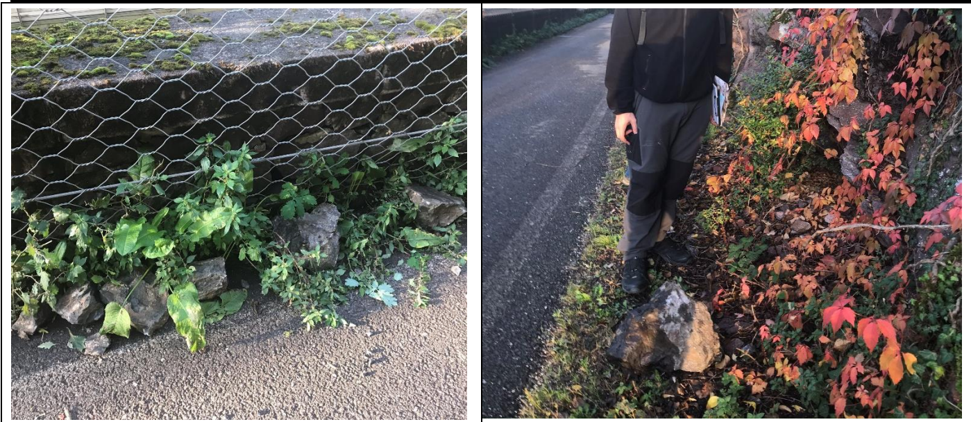
Figura 42. Blocchi giunti sulla sede stradale di via del Calvario (ottobre 2019).
