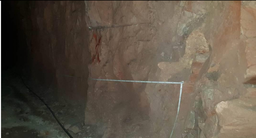
Figura 24. Condizione dell'ammasso roccioso alla pk 0+180 m circa dall'imbocco.
