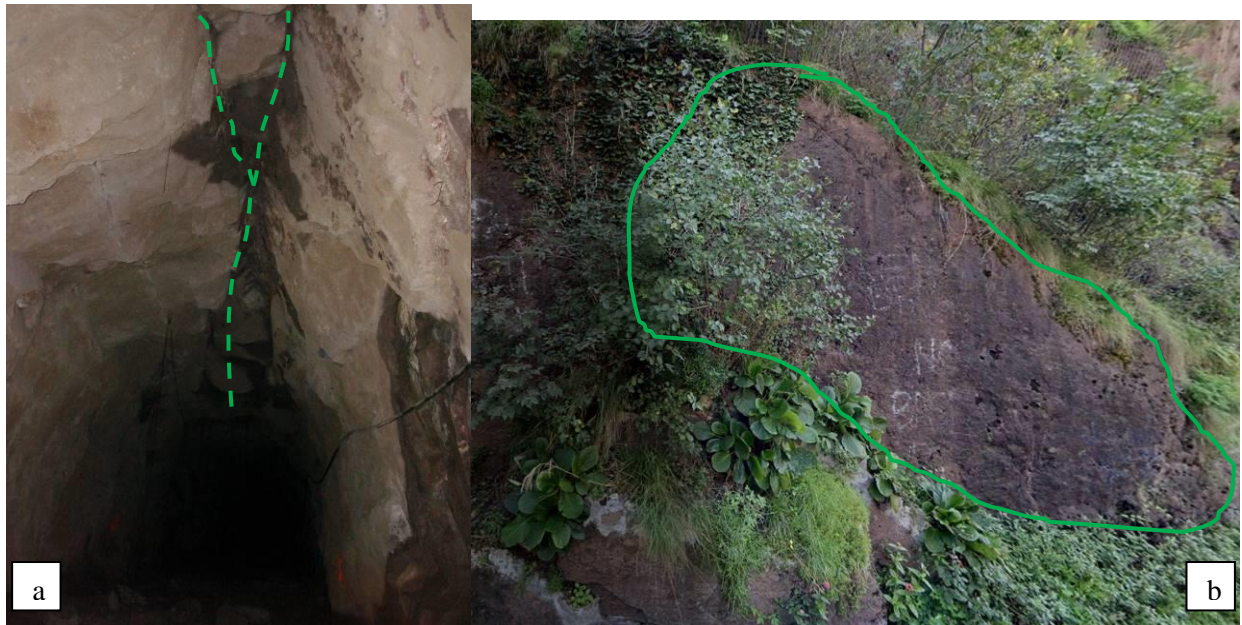
Figura 14. Esempio di struttura S1 lungo la volta del cunicolo esplorativo (a) e in corrispondenza della prima cappella di Via del Calvario (b).
