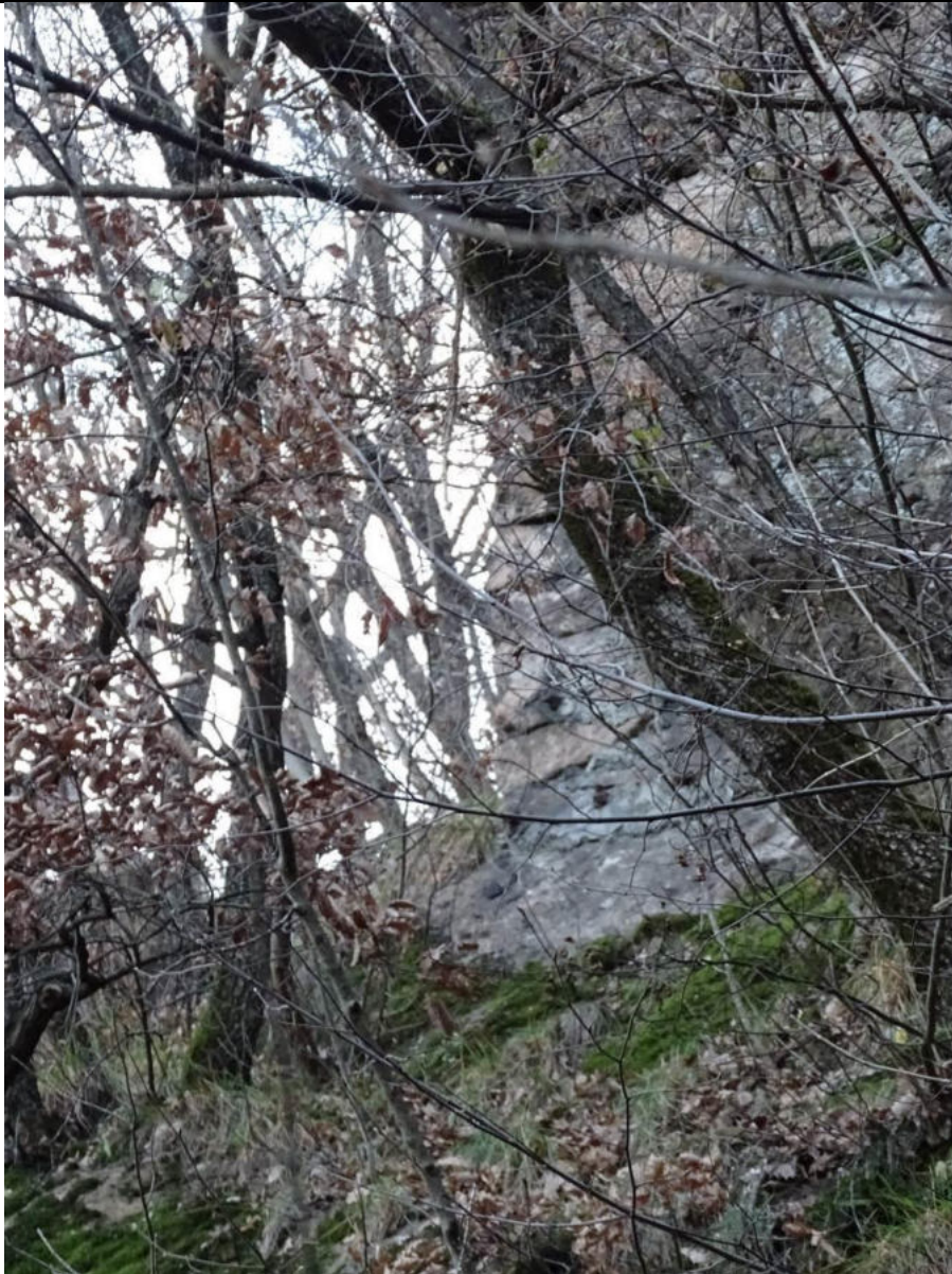
Figura 44. Muro di sottofondazione per stabilizzazione di volumi instabili
