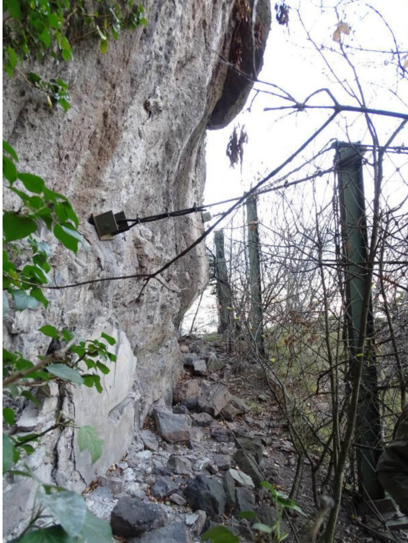
Figura 77. Vecchia barriera paramassi al WP 1473
