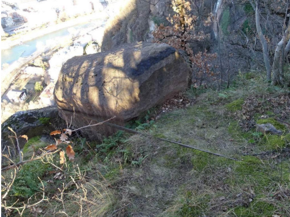
Figura 33. Masso plurimetrico con legatura metallica
