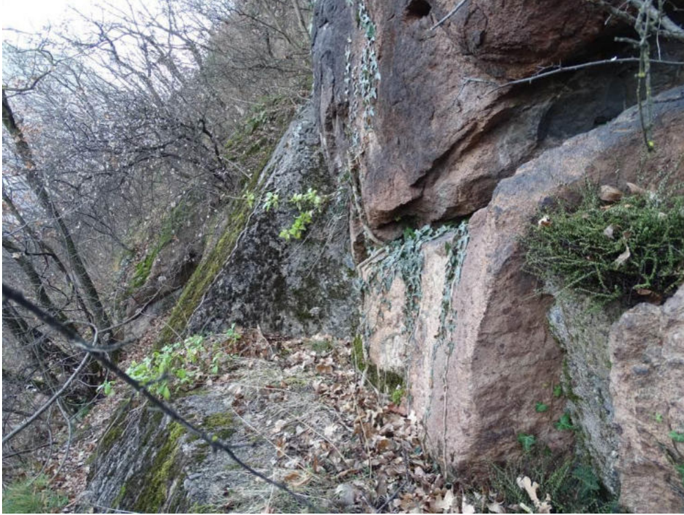
Figura 62. Muro di sottofondazione per blocco decametrico
