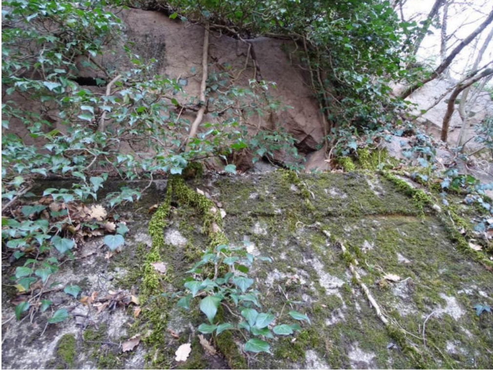
Figura 59. Muro di sottofondazione
