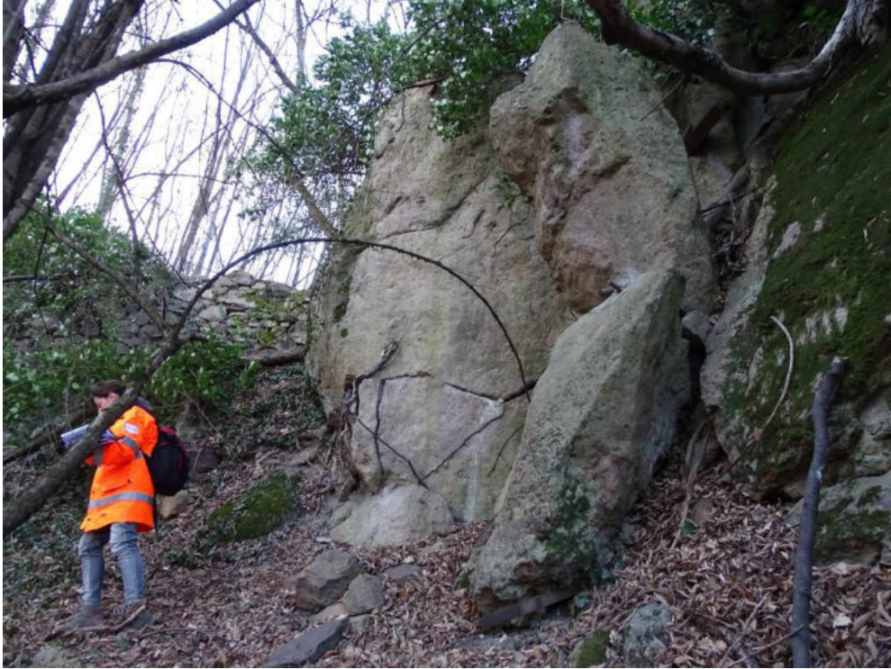
Figura 41. Parete con blocchi svincolati
