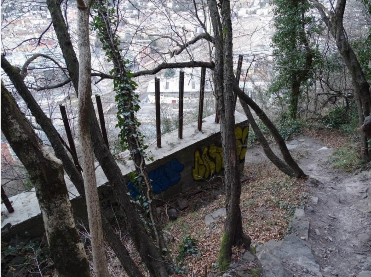
Figura 49. Muro in calcestruzzo con elementi metallici (spezzoni di binari ferroviari)
