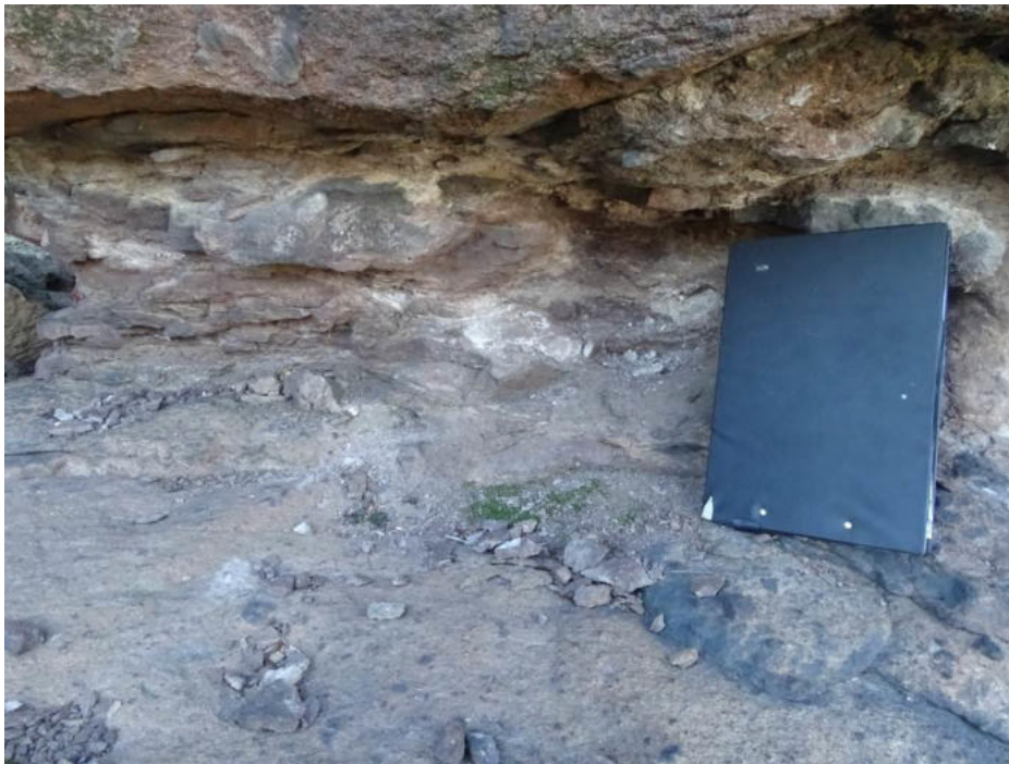
Figura 52. Erosione al piede del blocco che aumenta il rischio di instabilità
