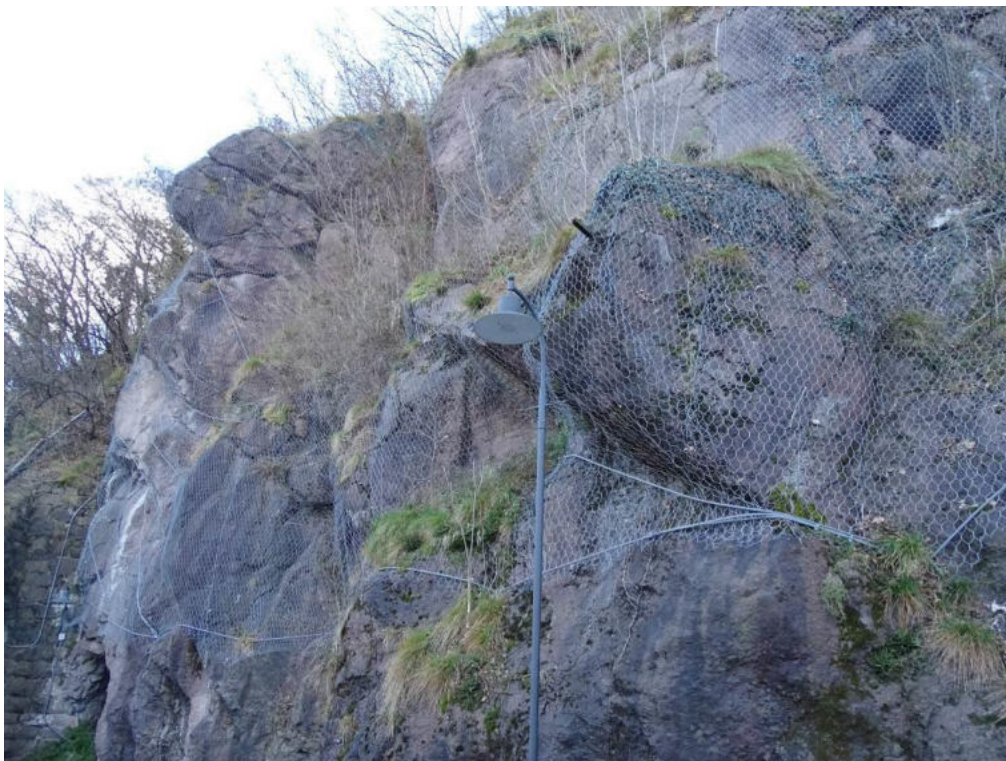
Figura 15. Particolare della parete con masso in aggetto chiodato
