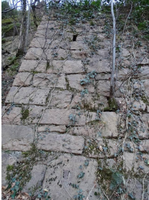
Figura 46. Muro di sottofondazione
