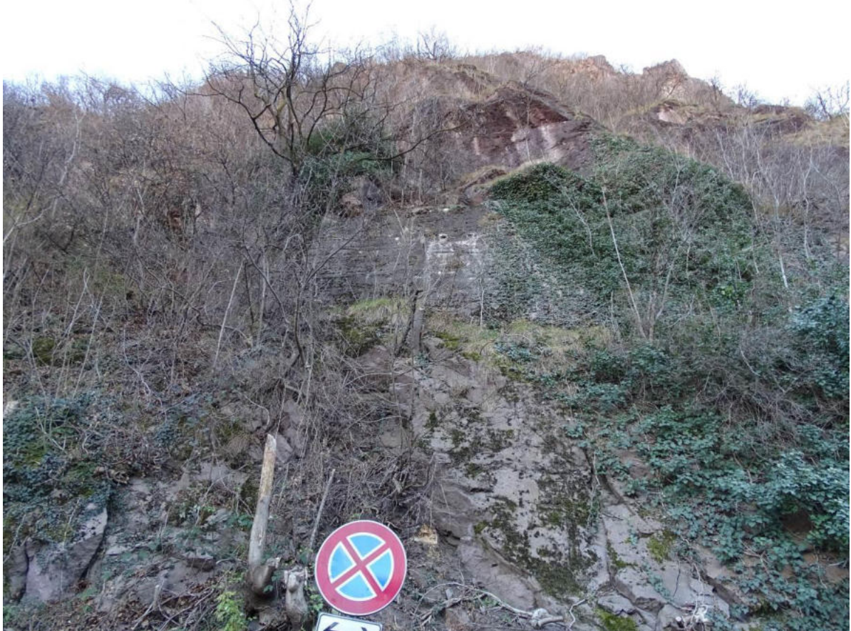
Figura 12. Muro di sottofondazione su parete verticale sopra Via Calvario. Stop 1441.
