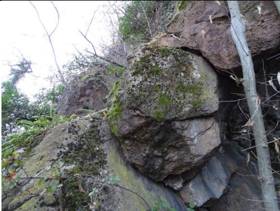
Figura 54. Blocchi plurimetrici, potenzialmente instabili, incastrati tra loro
