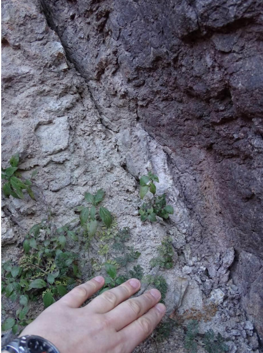
Figura 17. Particolare di faglia con presenza di una zona centimetrica di danneggiamento
