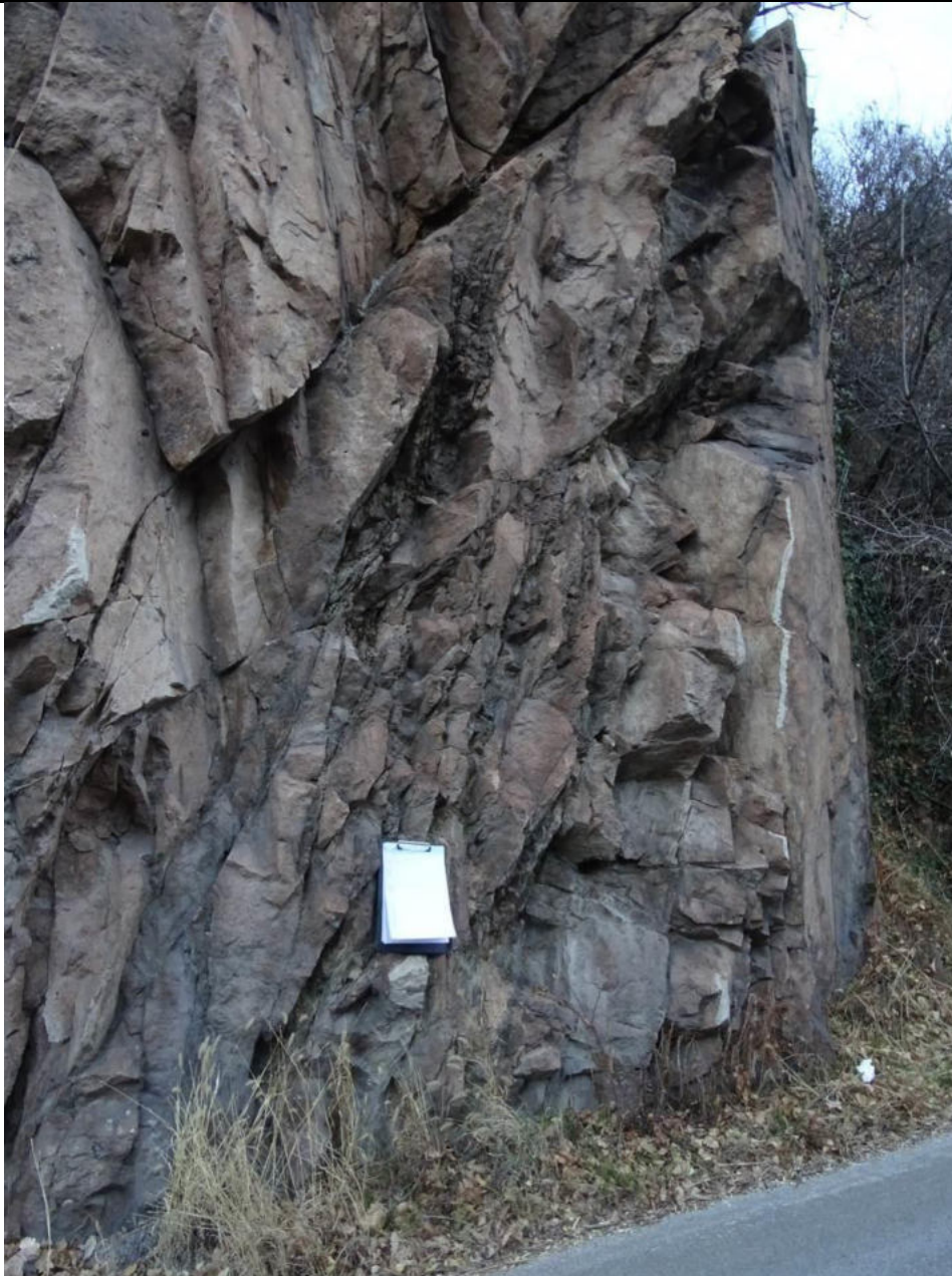
Figura 104. Parete con presenza di una fascia subverticale tettonicamente disturbata
