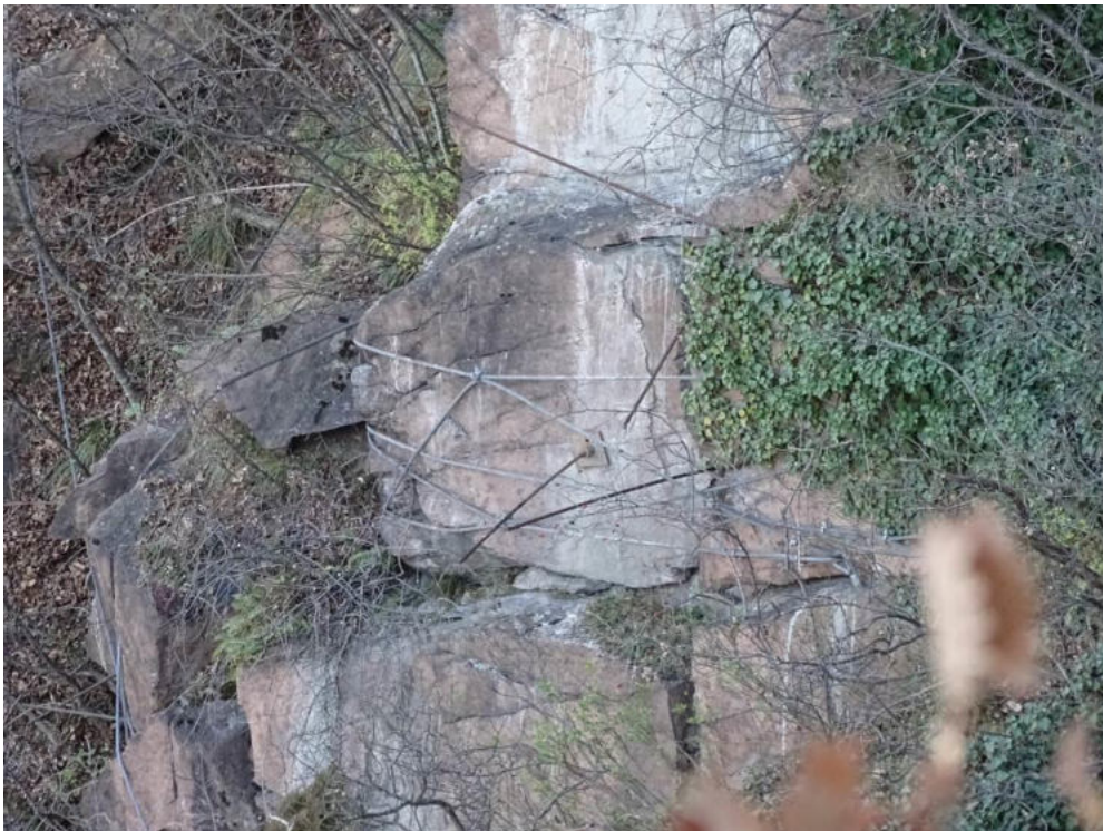
Figura 34. Massi alla testa della parete opposta con legature e chiodature
