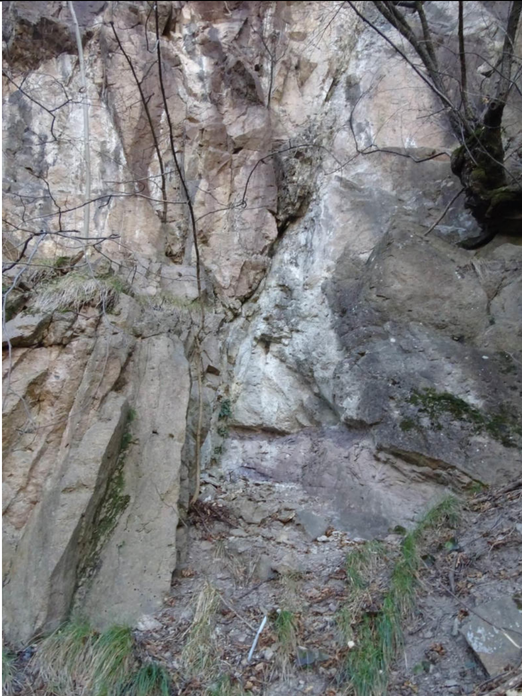
Figura 117. Piano di faglia nella zona nord. Sentiero 4B
