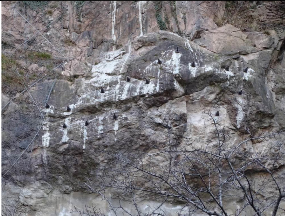
Figura 19. Parete in aggetto allo sbocco nord della galleria della SS12
