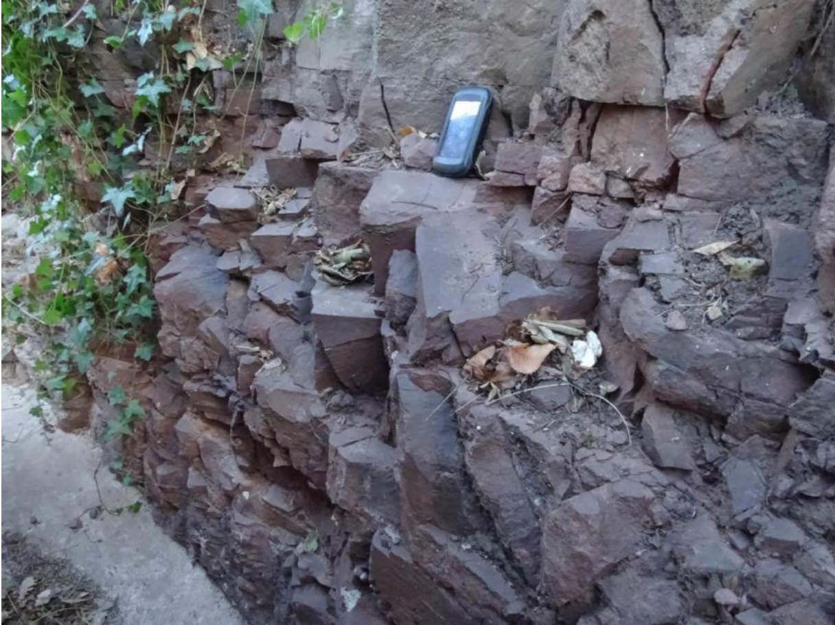
Figura 126. Affioramento ignimbrico IGR con elevato grado di fratturazione, forse parzialmente indotto dallo scavo artificiale. Si osservano piani suborizzontali
