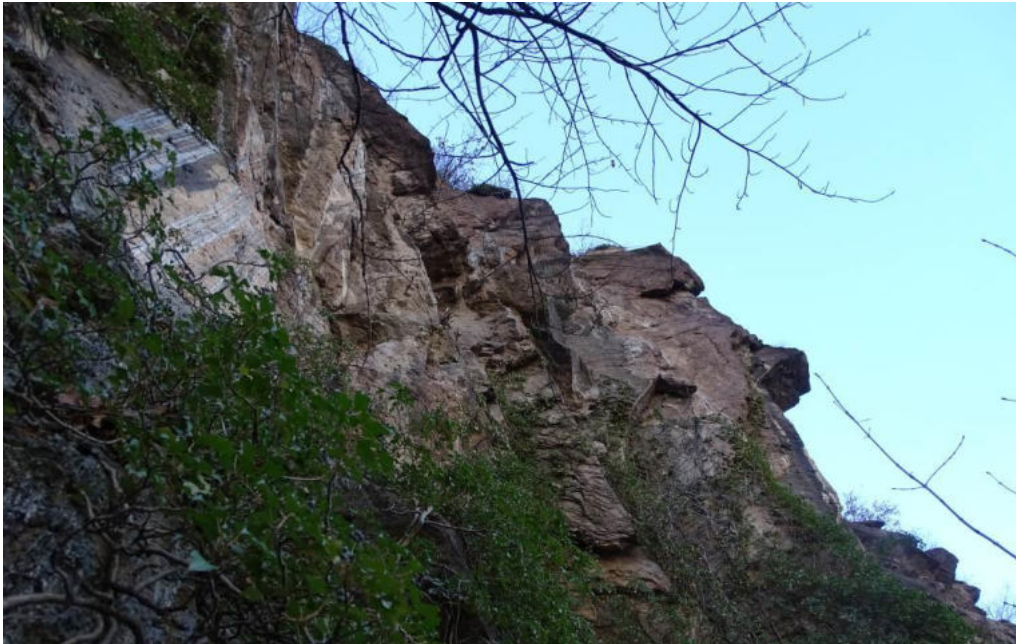
Figura 96. Porzione superiore della medesima parete con presenza di numerosi volumi potenzialmente instabili, plurimetrici, anche in aggetto
