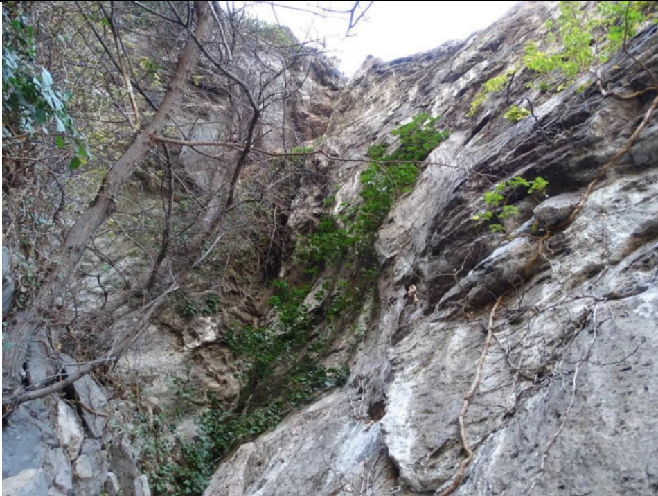
Figura 79. Zona di faglia con parete disturbata e presenza di numerosi volumi potenzialmente instabili
