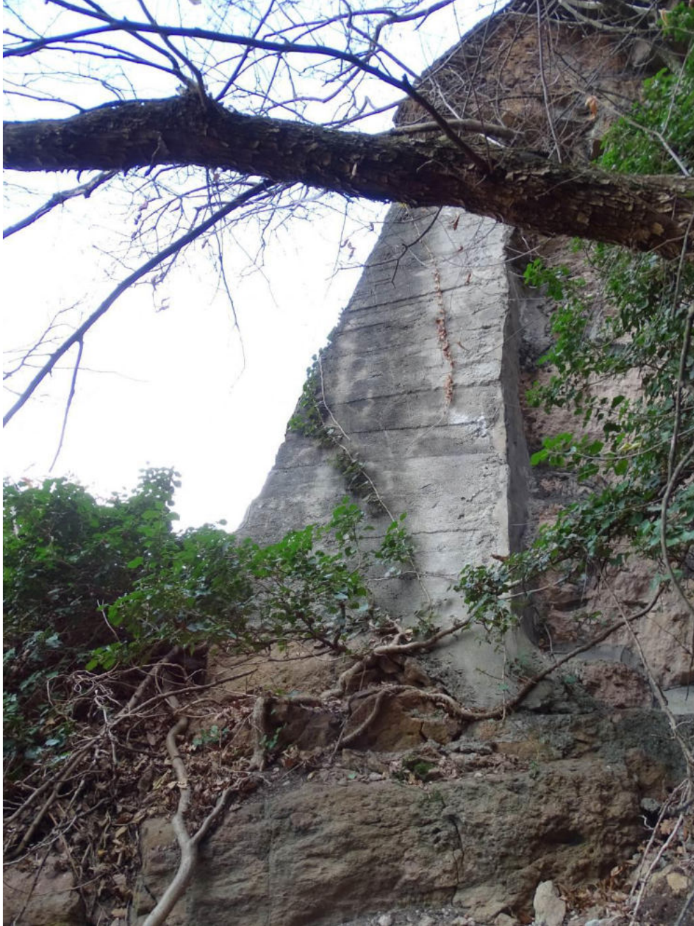
Figura 82. Muro di sostegno per blocco plurimetrico instabile a tergo
