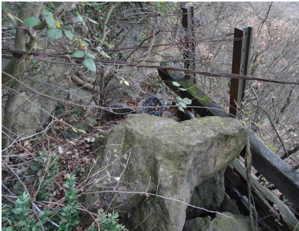
Figura 55. Opera di ritenuta con traversine e binari a valle dei blocchi della figura precedente
