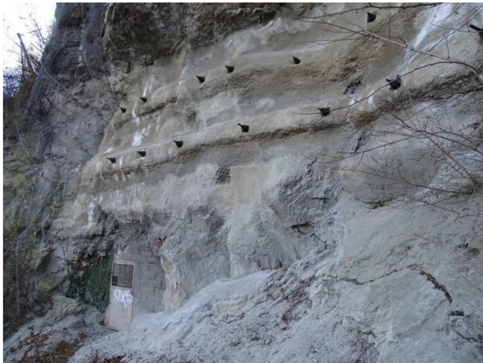
Figura 20. Particolare dei consolidamenti con spritz beton, chiodature e reti in aderenza
