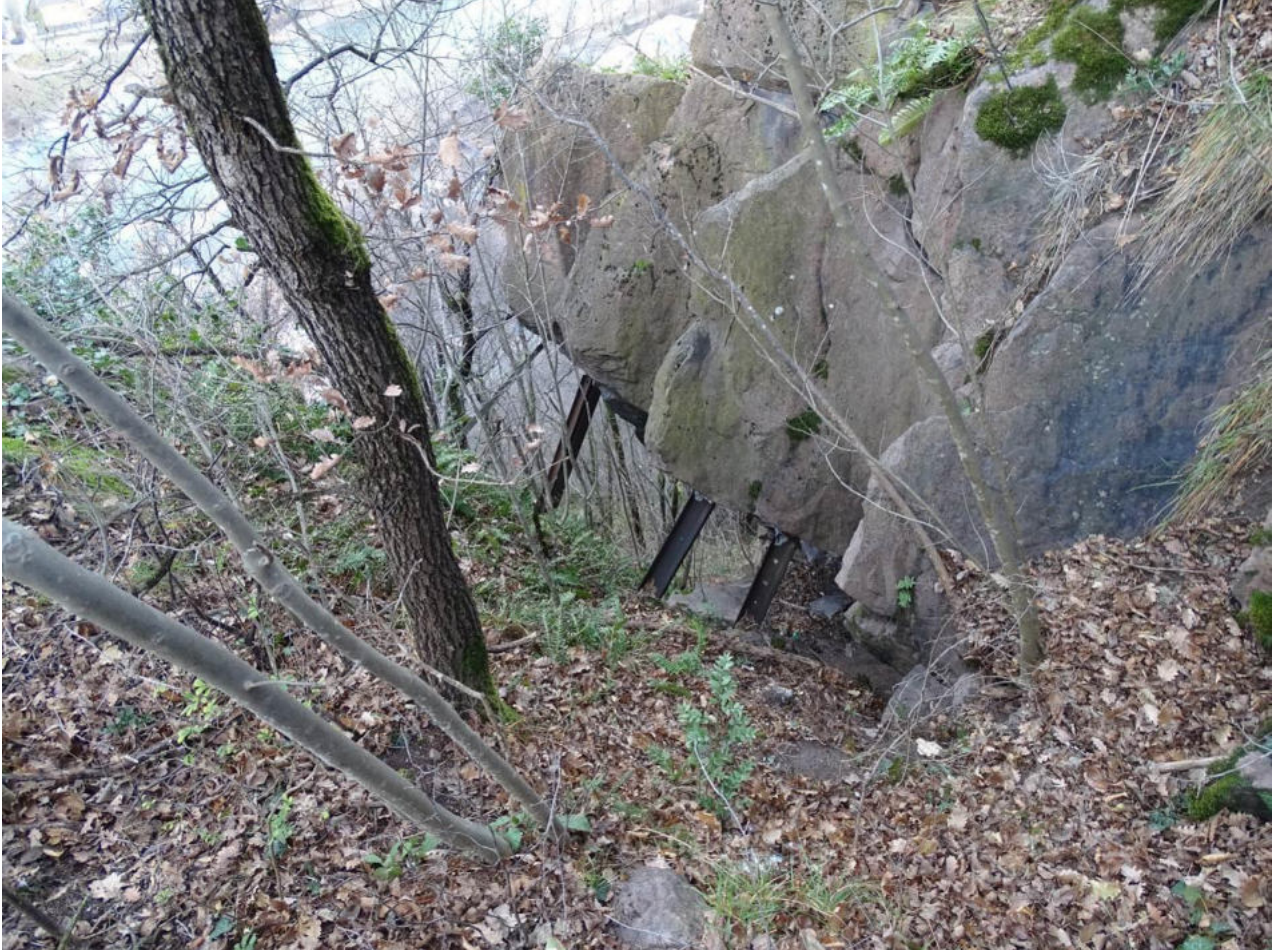
Figura 84. Opera di sostegno con binari ferroviari al ciglio della scarpata principale. Presenza di piano di faglia
