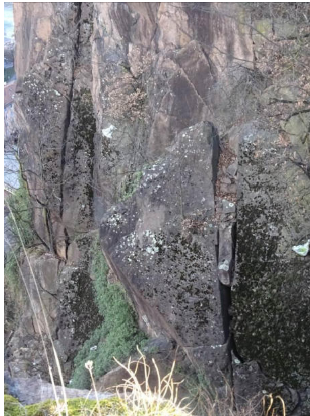
Figura 122. Blocchi cuneiformi plurimetri instabili
