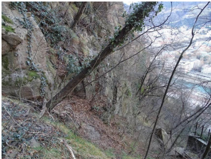
Figura 47. Cunei instabili in parete con vecchie opere di difesa passiva
