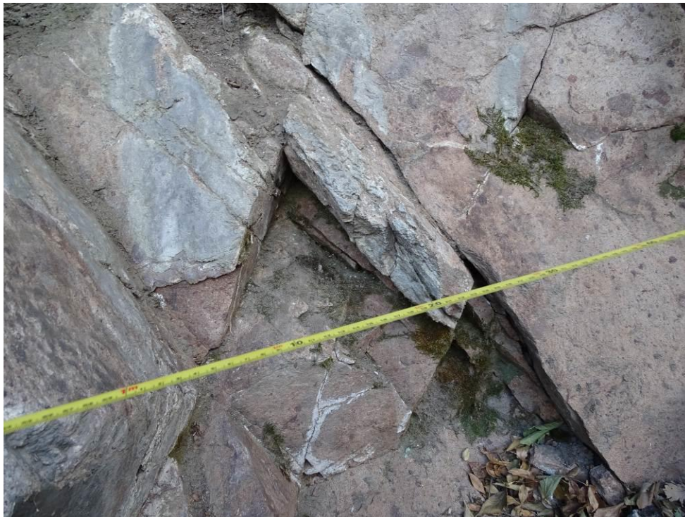
Figura 21. Scanline WP1483 (particolare).
