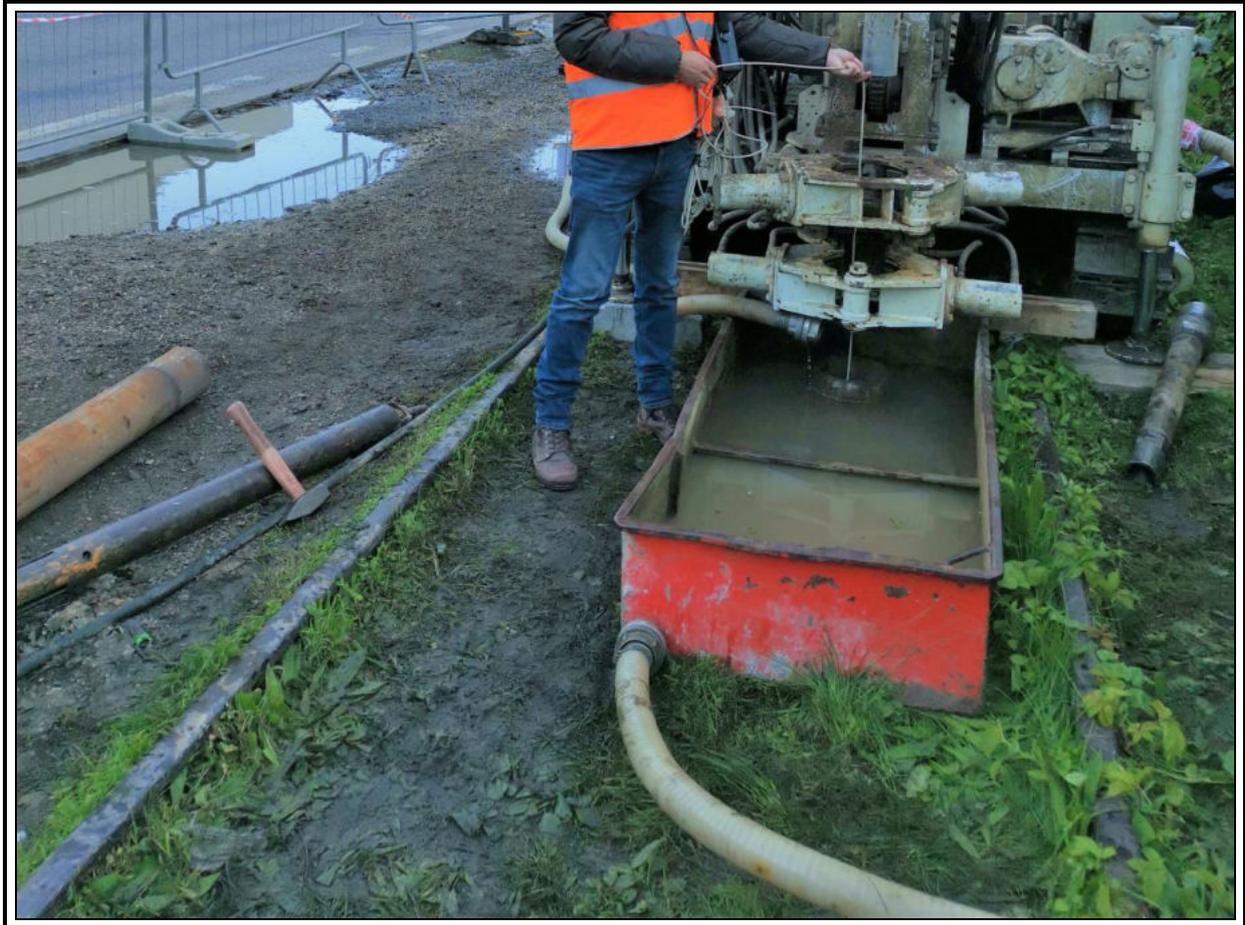
**Sondaggio VG5-Rilievo masse metalliche in foro**
