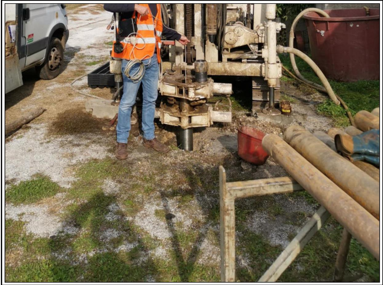
**Sondaggio VG0-Rilievo masse metalliche in foro**
