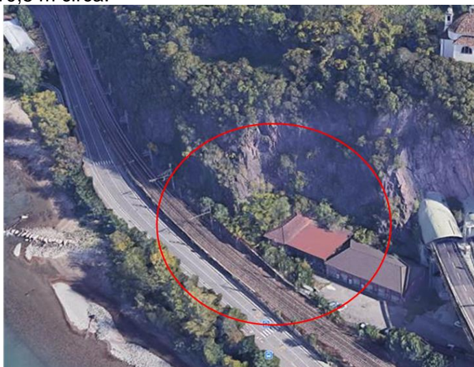
Figura 53. Zona di imbocco lato Verona (fonte Google Maps)
