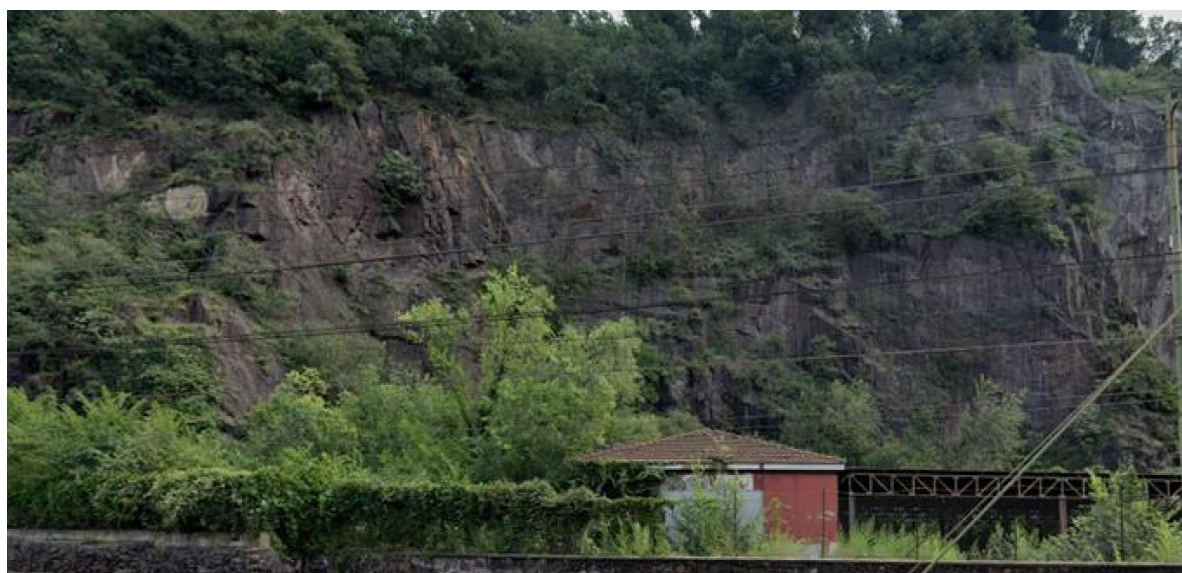
Figura 54. Parete rocciosa imbocco lato Verona (fonte Google Maps)
