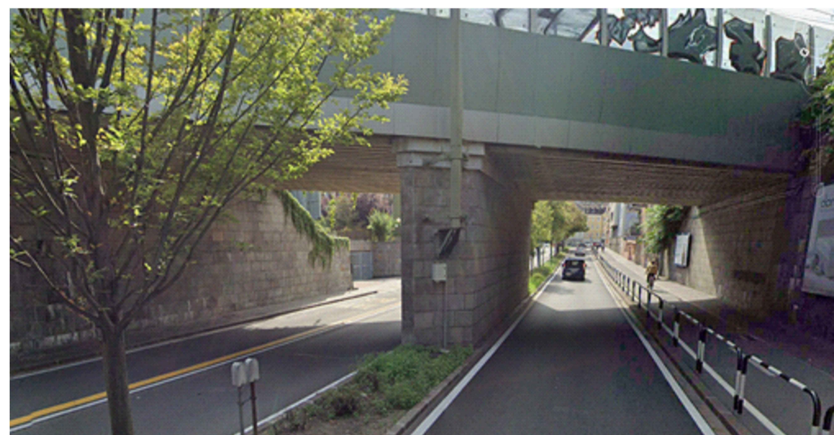
IMMAGINE PONTE ESISTENTE ESTRATTA DA GOOGLE EARTH
