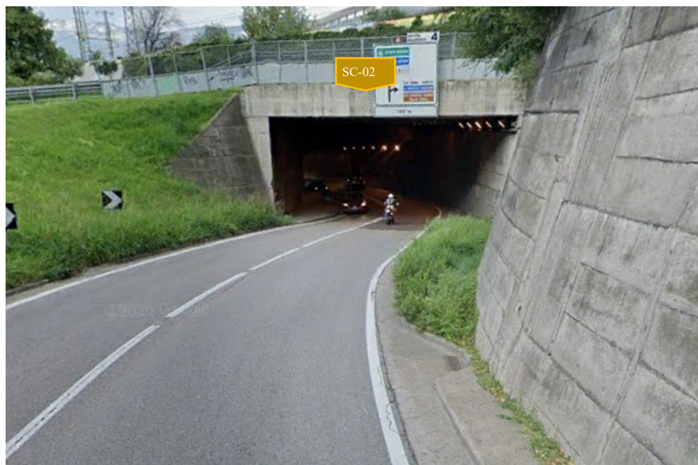
Figura 11. Galleria da demolire
