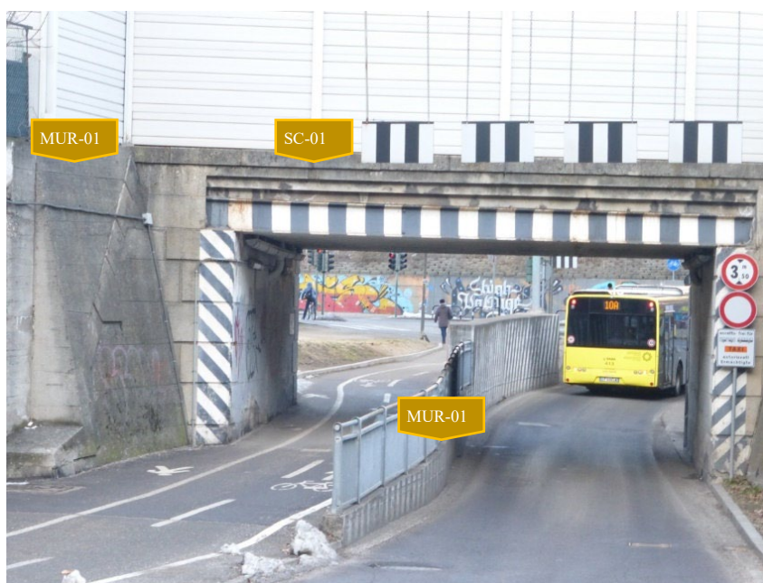
Figura 9. Sottopasso scatolare esistente in via Gertrude
