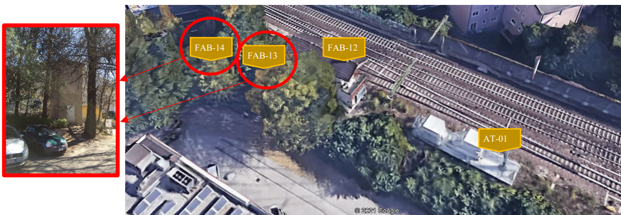
Figura 7. Casello FS, Apparati tecnologici - Deposito e Cabina elettrica (in dettaglio)
