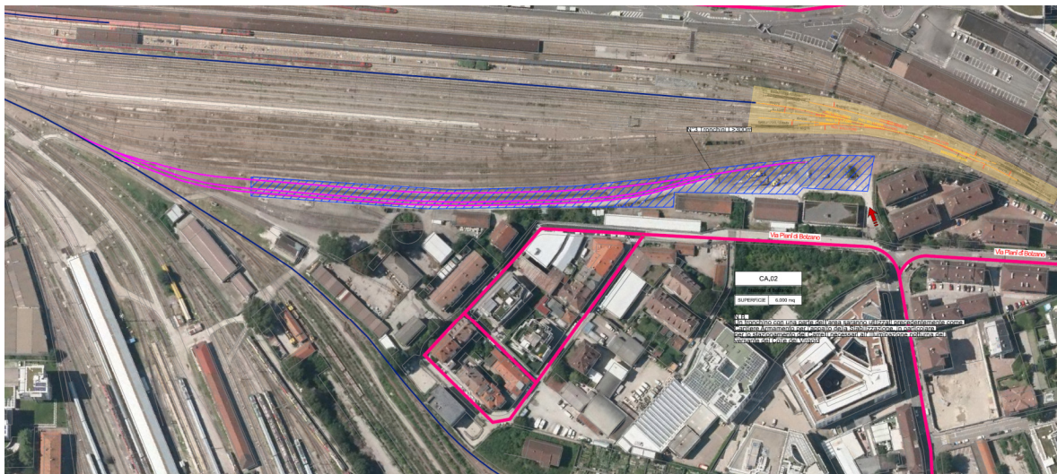
Vista aerea del CA.02
