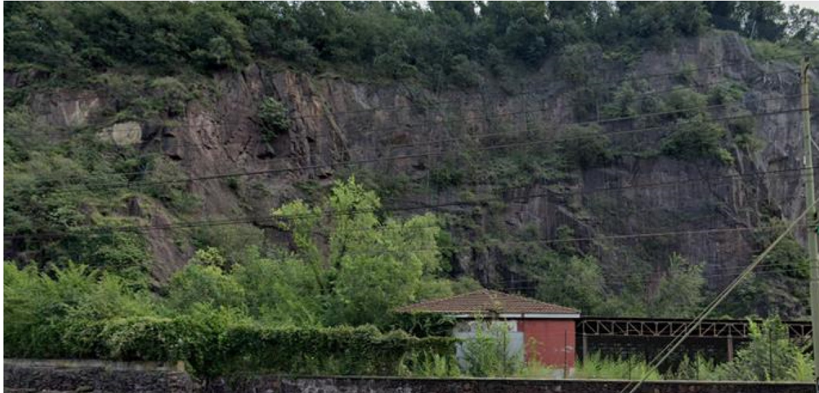
Figura 11 Parete rocciosa imbocco lato Verona (fonte Google Maps)
