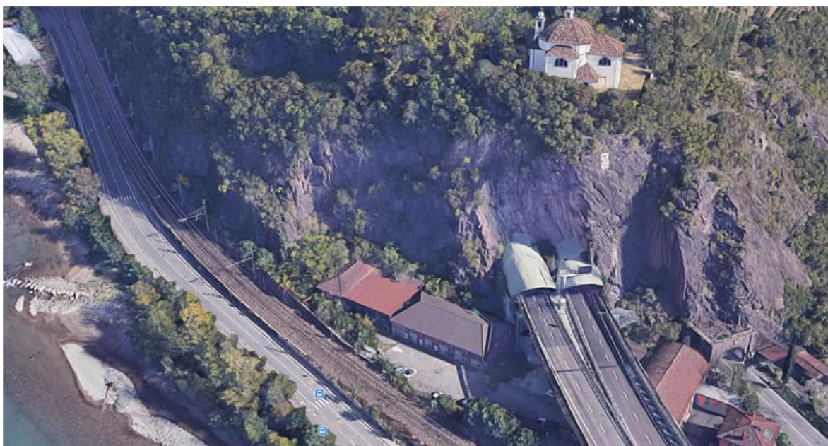
Figura 10 Zona di imbocco lato Verona (fonte Google Maps)
