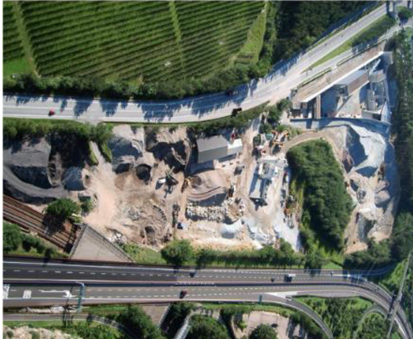
Figura 3-2 Impianto Beton Eisack
