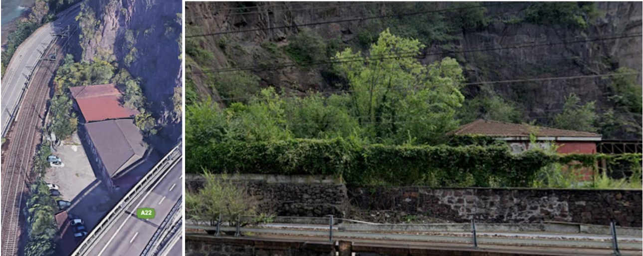
Figura 5-39 Vegetazione sinantropica presso l'imbocco in galleria lato Verona (Fonte: Google Earth, 2021)
