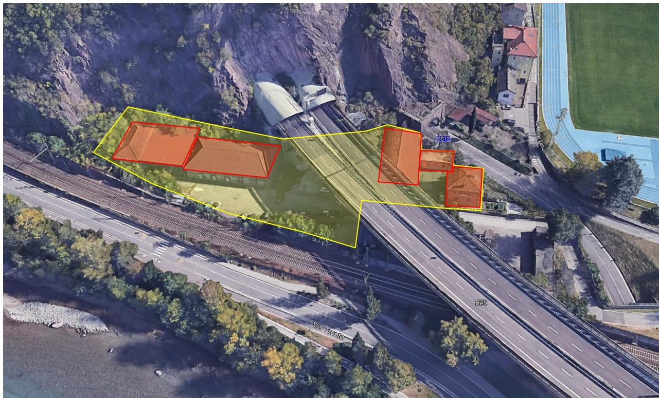
Figura 20 – areale ex ANAS (in giallo), edifici in demolizione (rosso)
