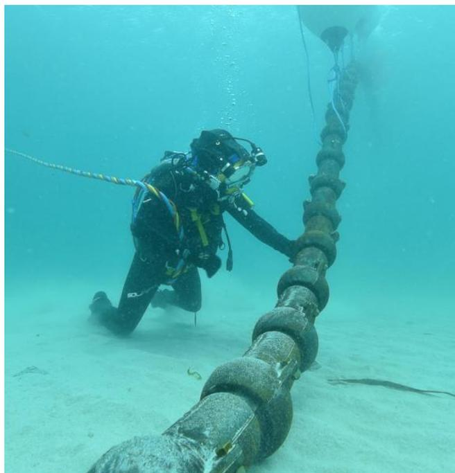
Figura 4-13: Esempio di metodo di posa con gusci di protezione
