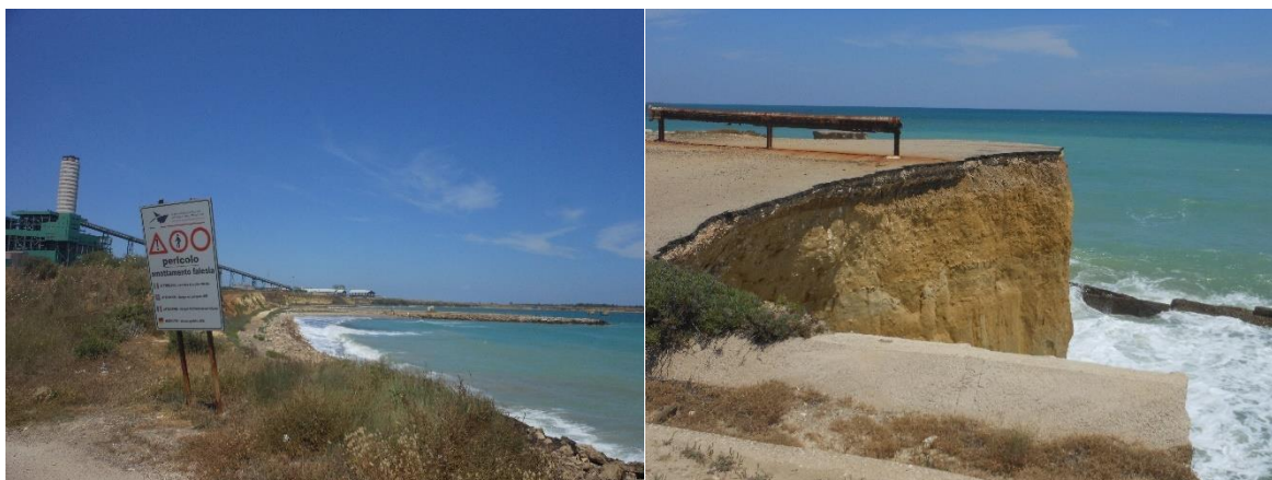
Figura 4-22: Indicazione di Pericolo smottamento falesia e crollo della sede stradale costiera immediatamente a sud del centro produttivo (punti di vista 9 e 10 in carta)
