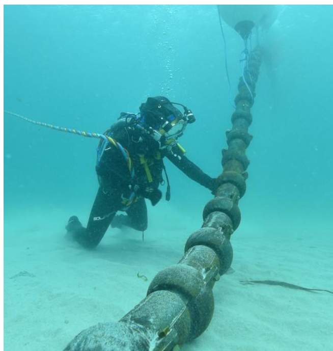
Figura 3:10: Esempio di metodo di posa con gusci di protezione
