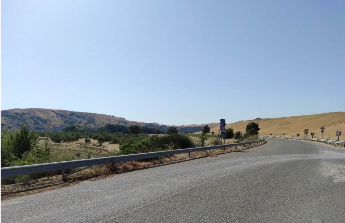
Vista 11 lungo la SP4 (Viadotto Salandrella V), lungo nr. 66 MT tratturo di San Leonardo, ante operam
