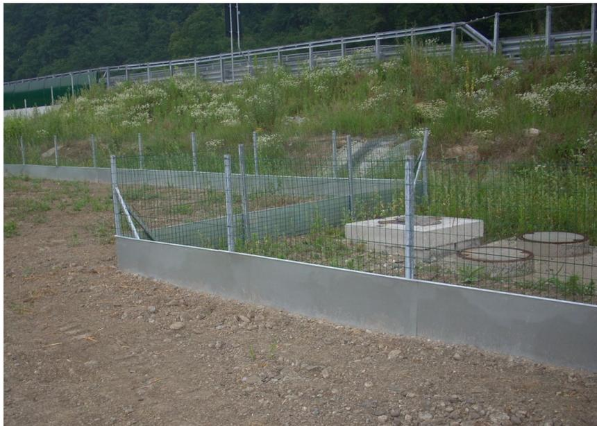
Figura 2.4 - Esempio di installazione del lamierino su recinzione.
