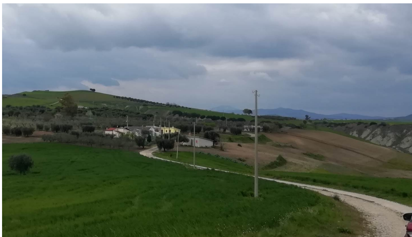
Masseria Panacce – complesso di fabbricati, censiti come depositi, lungo la strada comunale
