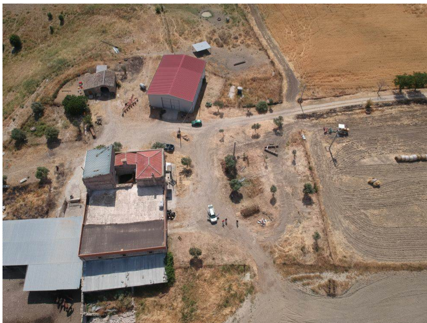
Masseria Scorpione – accessibile da strada privata chiusa
