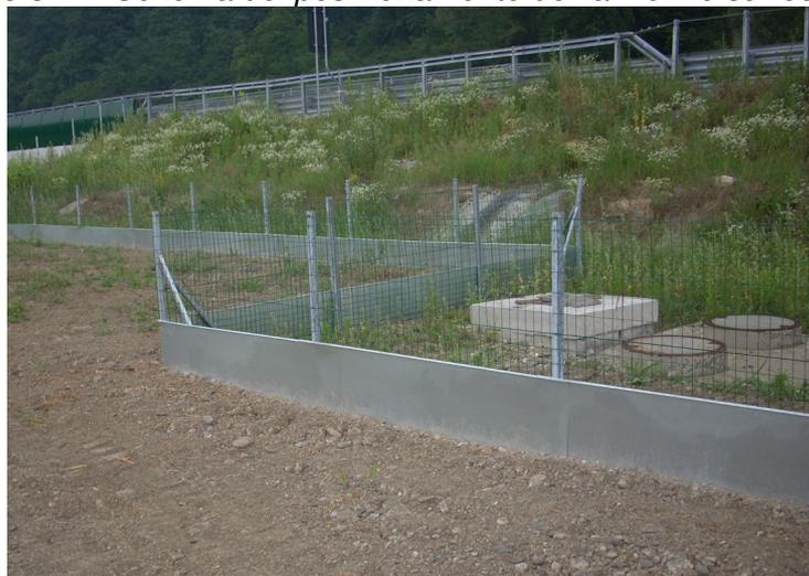
*Figura 5.3.B/1 –Esempio di installazione del lamierino su recinzione*
