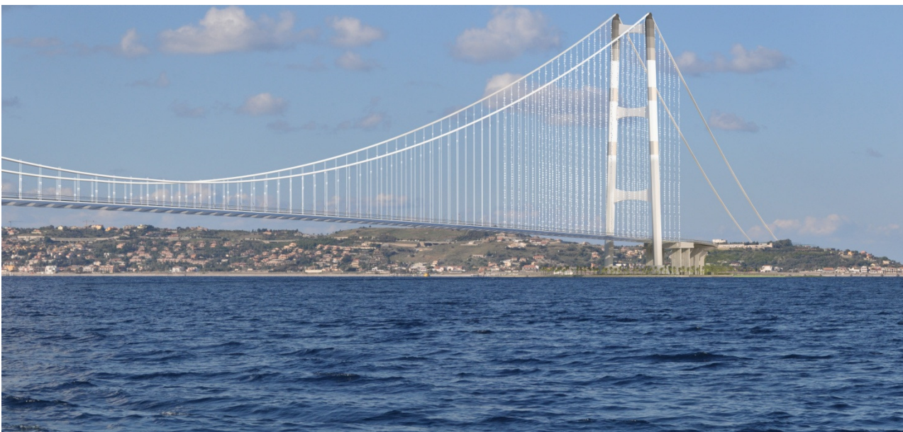
Figura 2.6 Simulazione con colorazione bianco riflettente e bande colorate e dispositivi per avvertimento visivo e sonoro sui pendini
