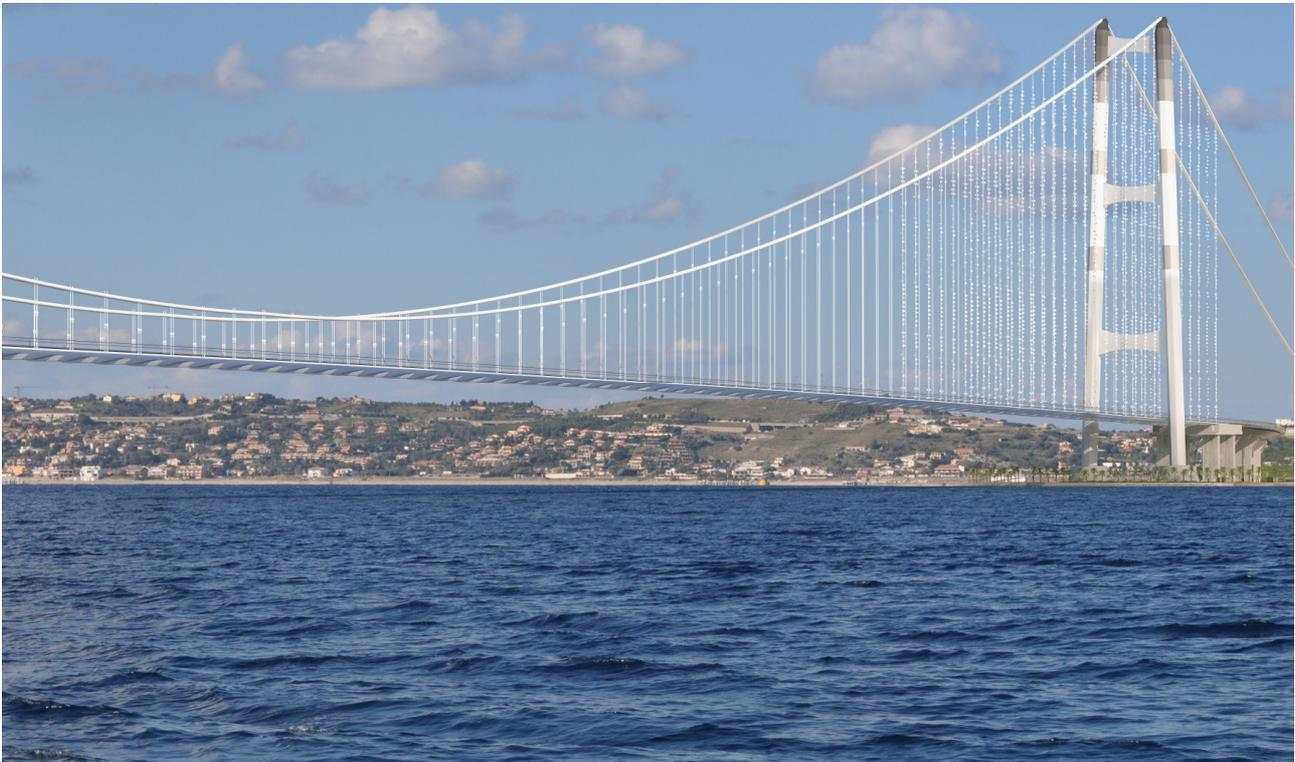
**Figura 3.7 – Ipotesi di sistemazione di elementi di avvertimento sui pendini – colorazione torri bianca/grigia**
