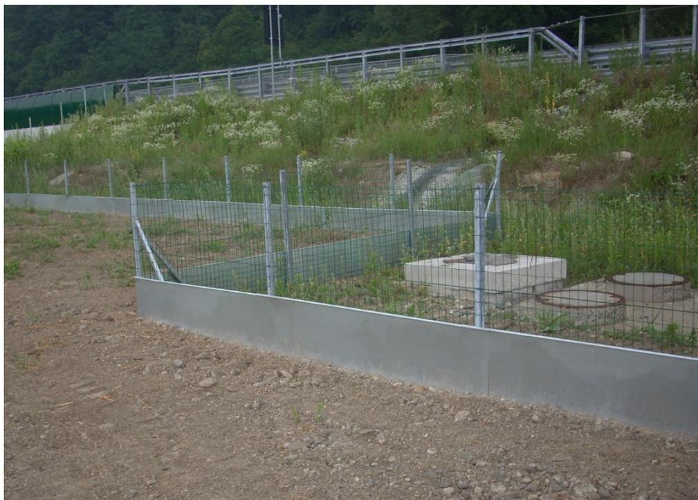
*Figura 3.4 – Esempio di installazione del lamierino su recinzione.*
