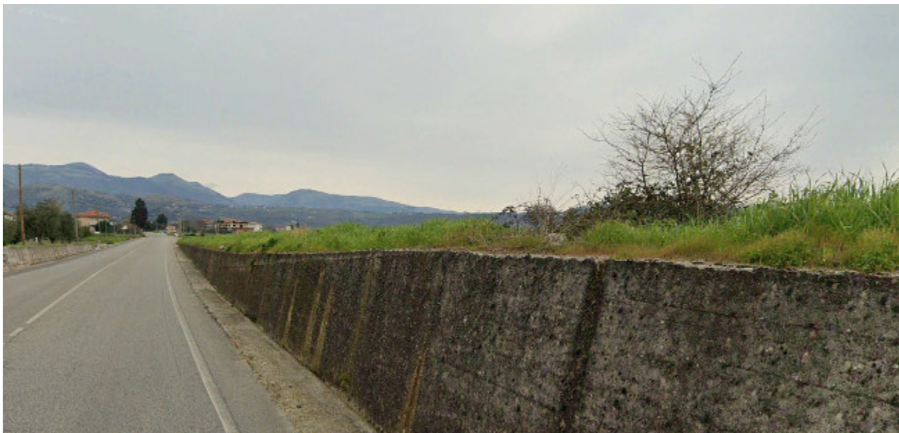
Vista dalla strada di accesso all'area tecnica.
