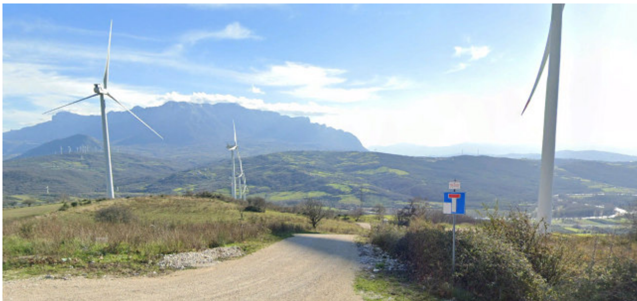
Vista della viabilità di accesso al deposito dalla SS91.
