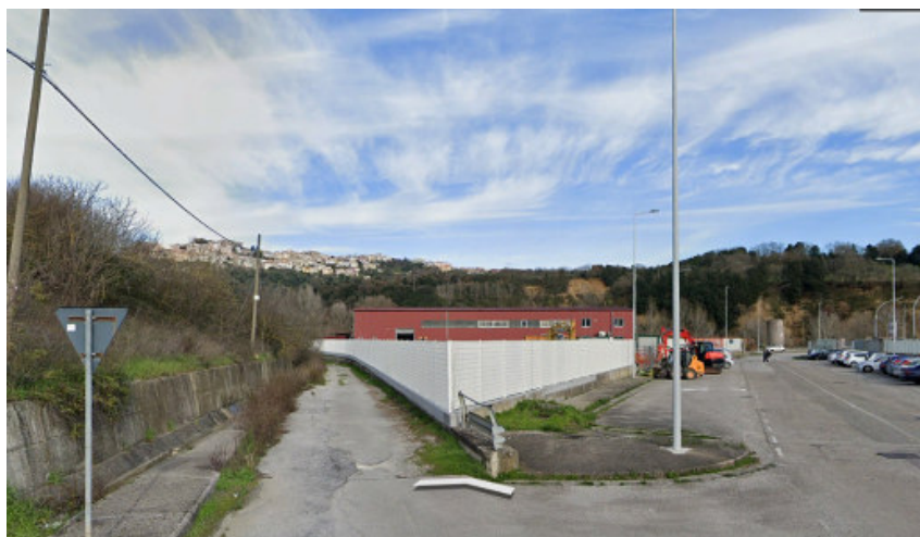
Accesso all'area tecnica dalla viabilità esistente.
