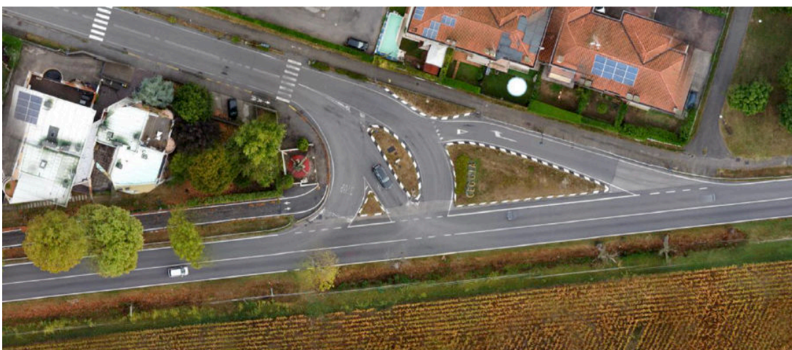
Fig. 2: Stato di fatto Fonte: lista di controllo
