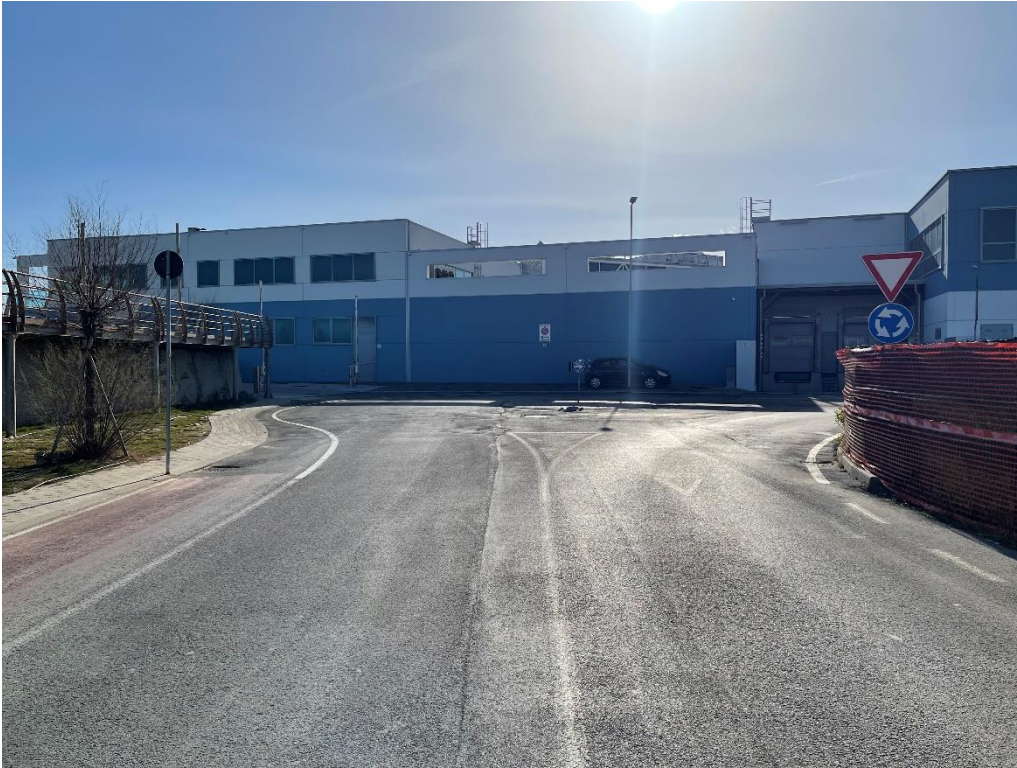
1. Vista da nord verso il capannone New Compramo
