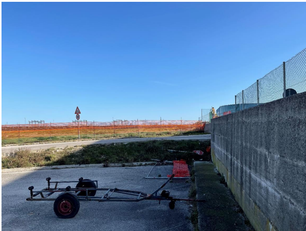
5. Vista da Nord – Ovest della vecchia diga di confine con l'area di intervento sulla sinistra.
