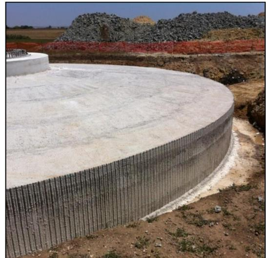
*Fig. 2.4 - Tipico fondazione a plinto prima del rinterro*
