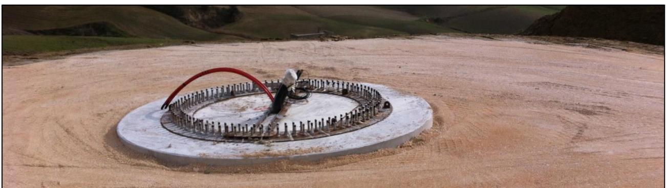
*Fig. 2.5:- Plinto interrato ed anchor cage*
